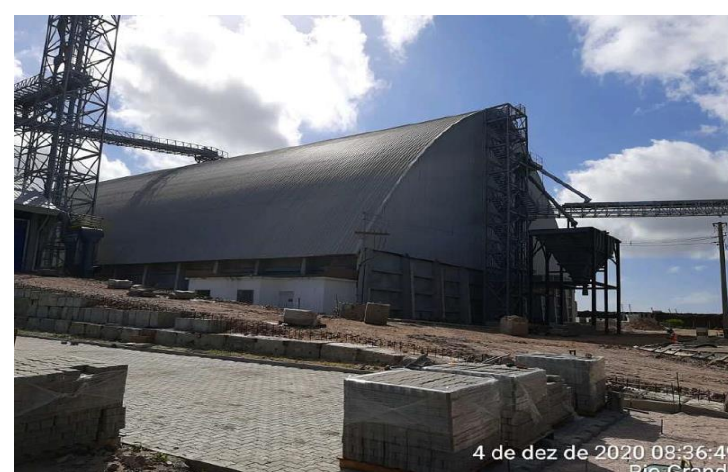
Armazenagem de grãos – Armazém 03.
