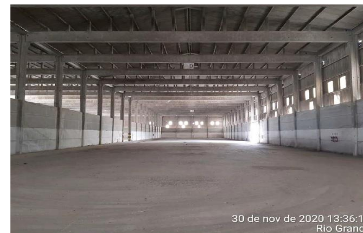
Armazenagem de grãos (Armazém 02)
