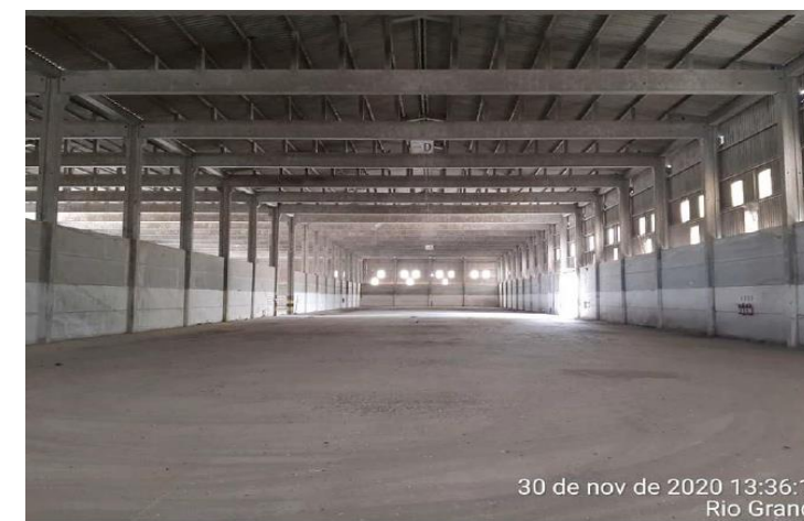
Armazenagem de grãos (Armazém 02)
