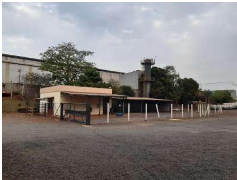
Vista do Almojarifado.
