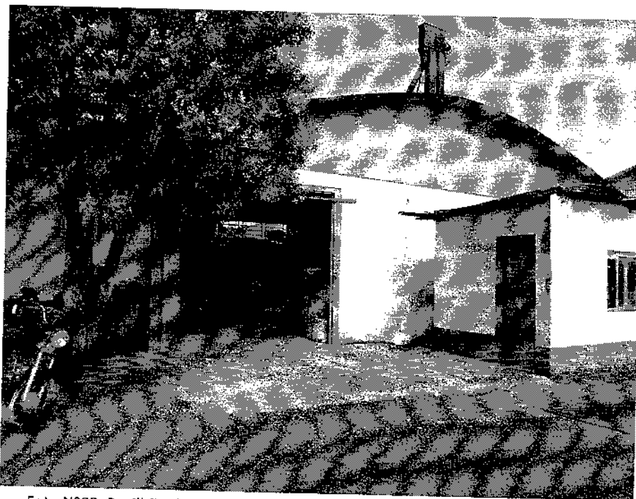
Foto Nº03: Pavilhão de armazenamento (Item 01 Quadro 2.4.1) e sala da balança.
