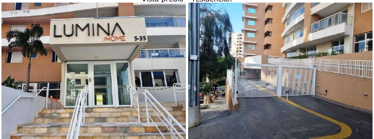
Vista entrada principal e acesso a garagem.
