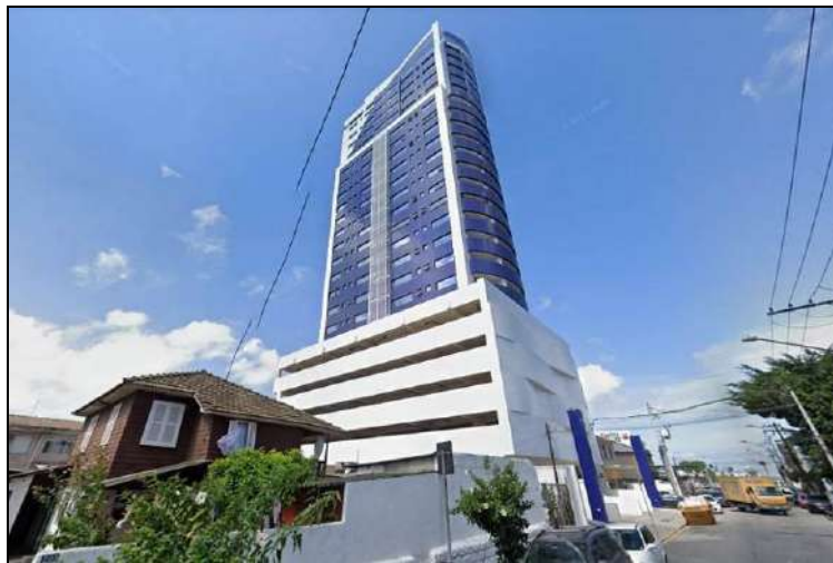
Vista parcial externa do empreendimento The One Office Tower.
