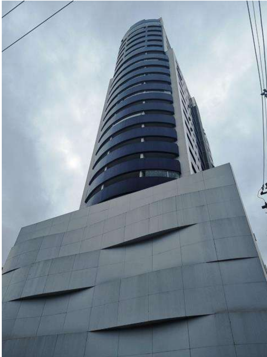
Vista geral do prédio.
