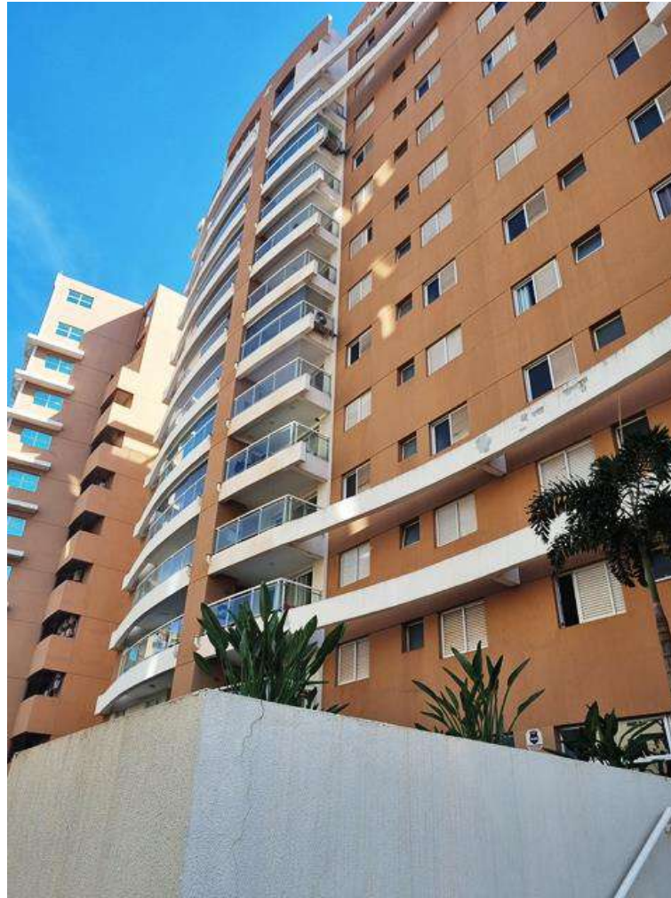
Vista prédio – residencial.
