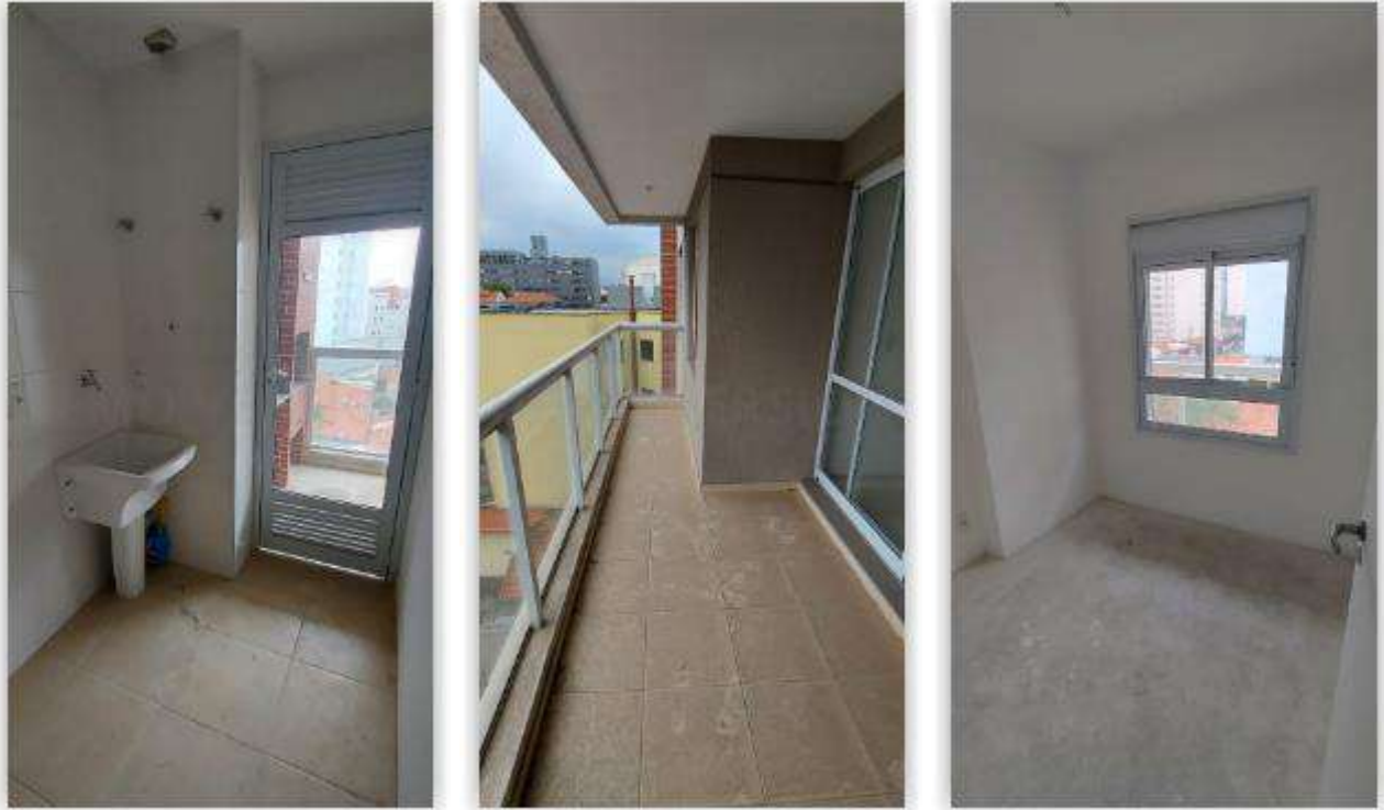
Área de serviço, varanda e quarto.
