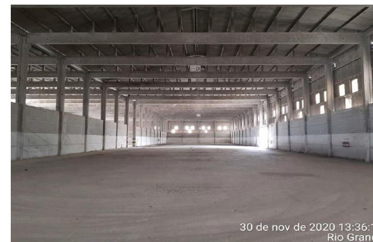
Armazenagem de grãos (Armazém 02)
