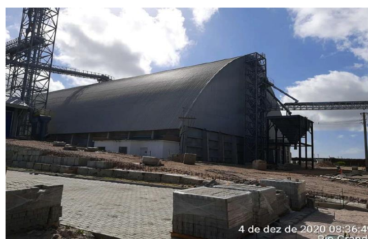
Armazenagem de grãos – Armazém 03.
