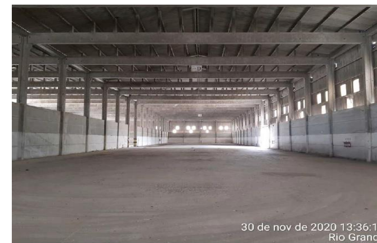
Armazenagem de grãos (Armazém 02)
