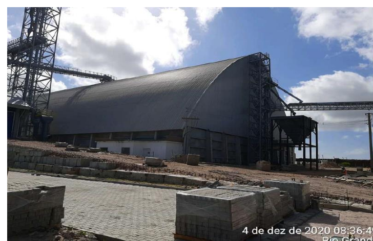
Armazenagem de grãos - Armazém 03.
