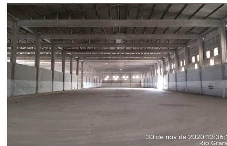
Armazenagem de grãos (Armazém 02)
