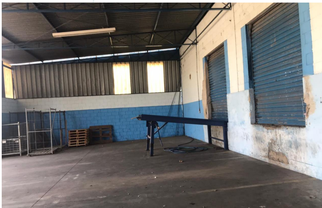
Foto 002: Doca de carga e descarga
