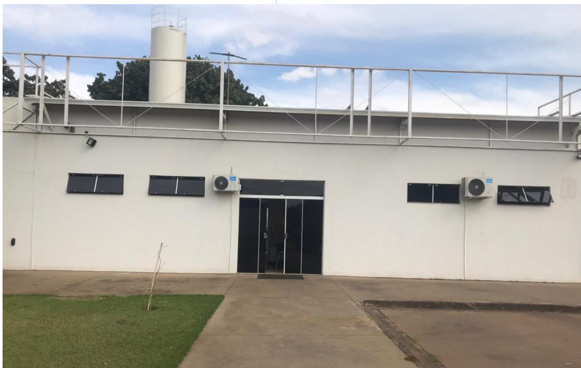
Foto 017: Entrada para as dependências da empresa
