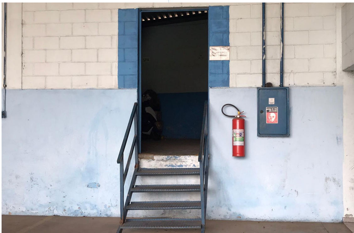
Foto 003: Entrada do Galpão de armazenamento de produtos para transporte
