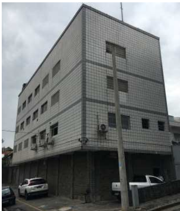
Foto 019: Fachada da unidade sito na Capital de São Paulo
