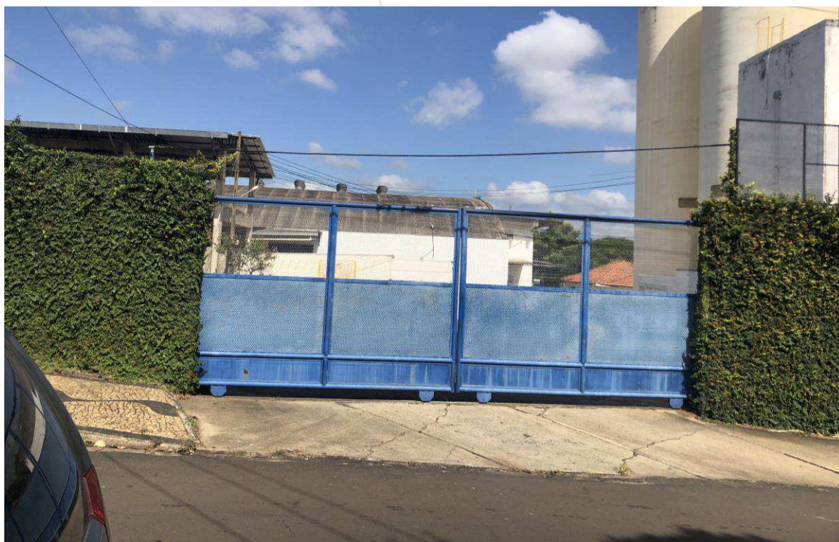
Foto 001: Entrada externa lateral
