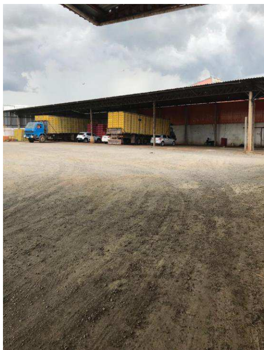
Foto 012: Setor de expedição preparado para despachos.
