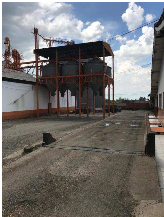
Foto 011: Maquinário para carregamento e distribuição (ângulo diverso).
