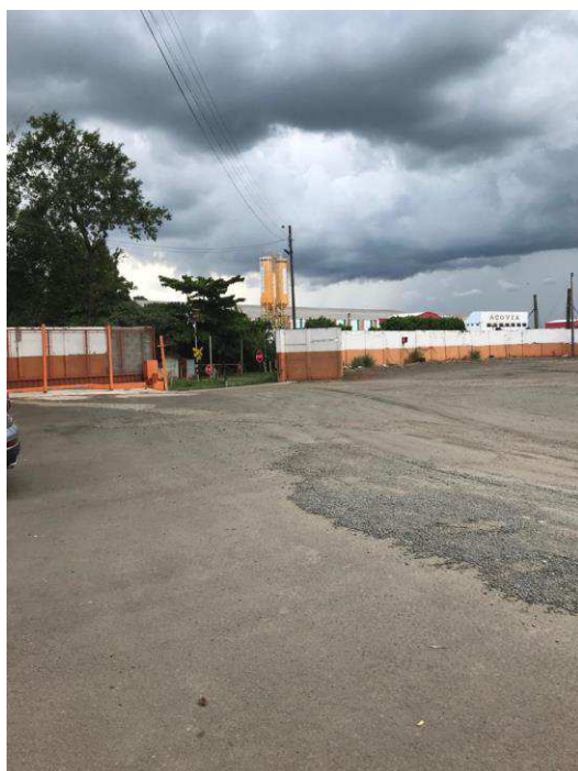
Foto 002: Pátio interno da empresa.
