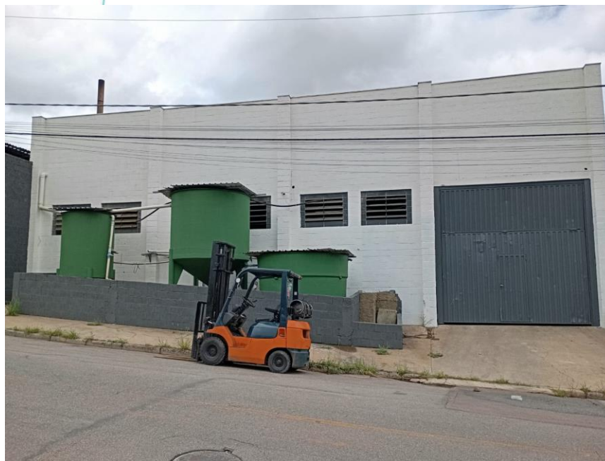
Foto 022 – Fachada do Galpão (continuação)
