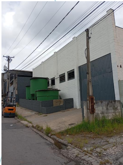
Foto 021 – Fachada do Galpão
