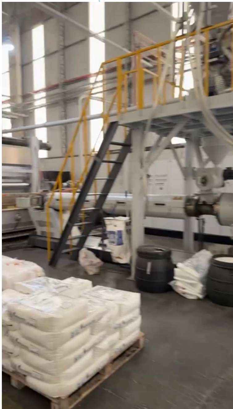
Foto 026: Escada de acesso da máquina de distribuição de insumos
