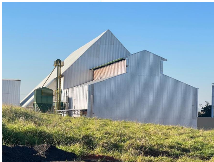
Foto 015: Galpão da empresa
