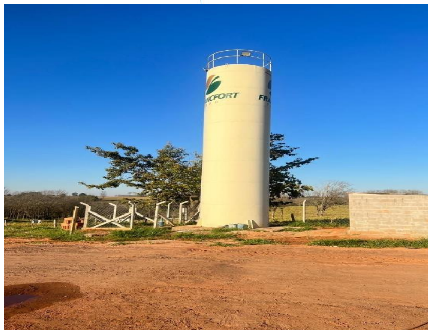
Foto 033: Tanque de armazenamento de água
