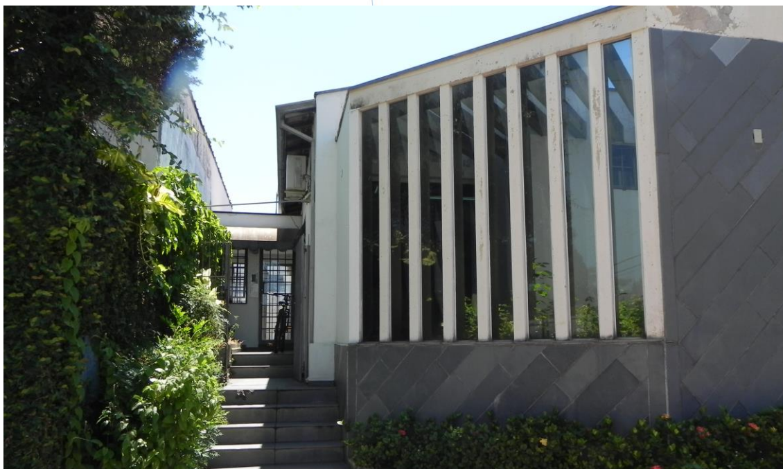
Foto 011: Entrada para o setor administrativo
