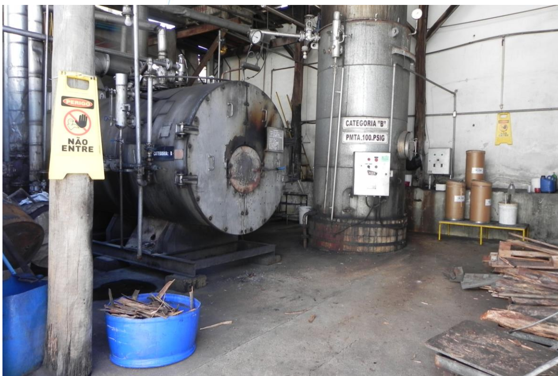
Foto 004: Sala das máquinas
