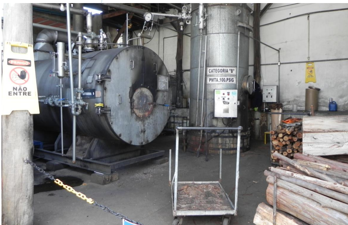
Foto 014: Sala das máquinas
