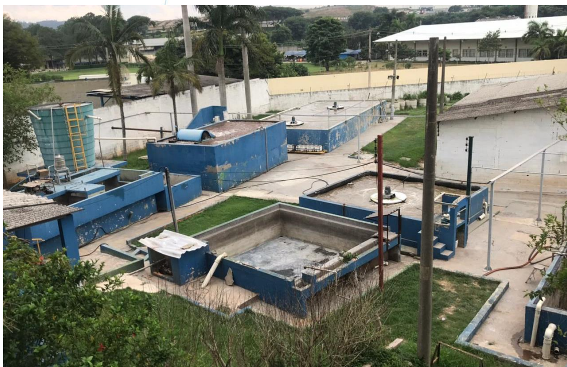
Foto 018: Estação de tratamento de água
