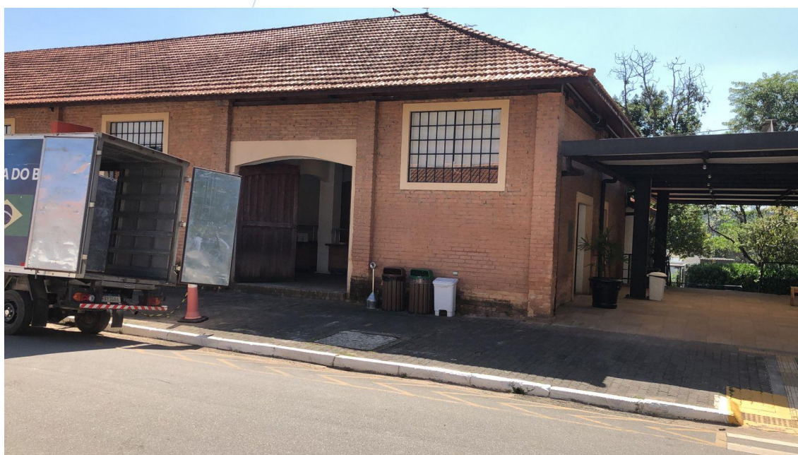
Foto 024: Entrada do refeitório 02.]
