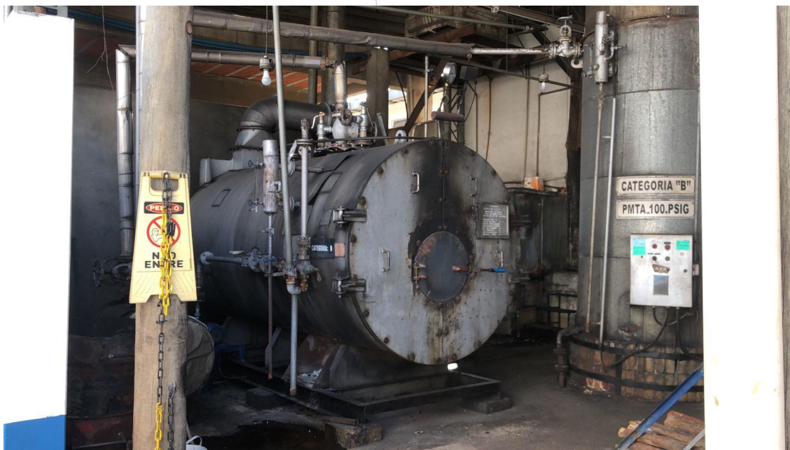
Foto 032: Forno de aquecimento de água
