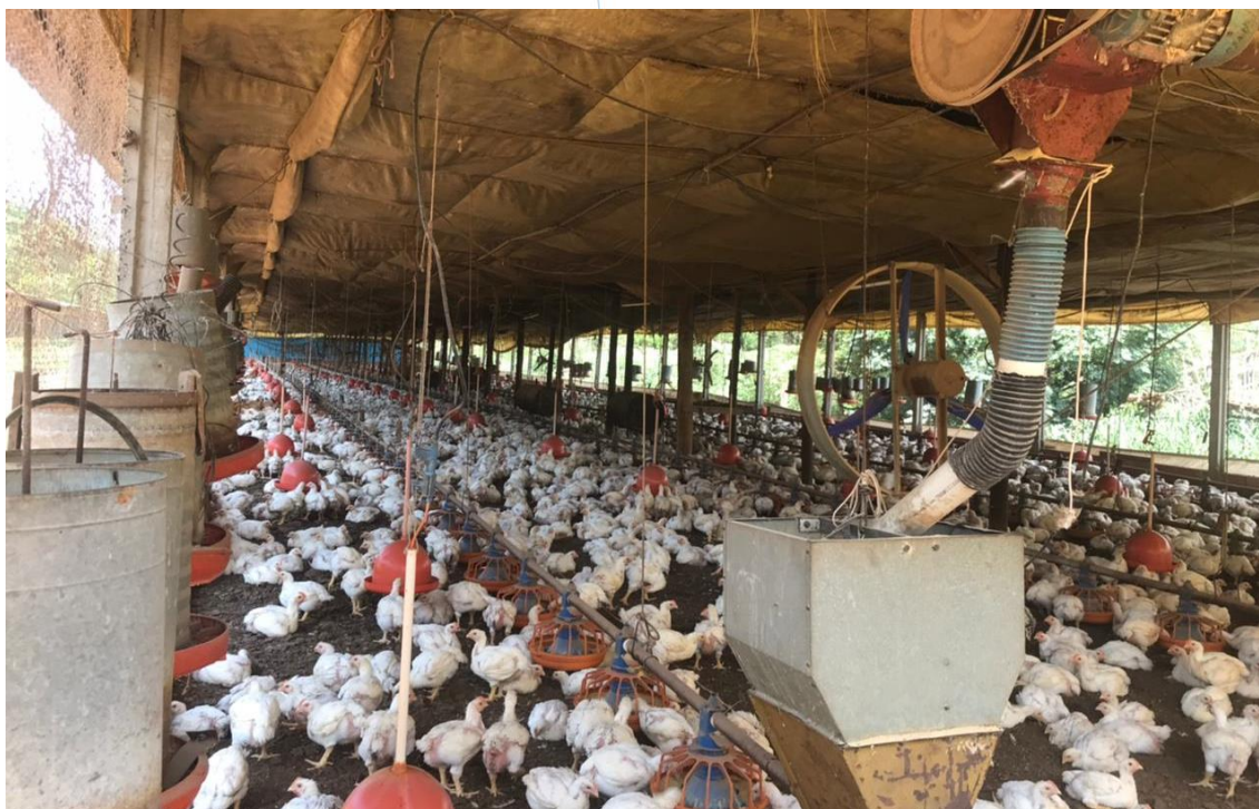
Foto 019: Instalação para engorda de frango (01)
