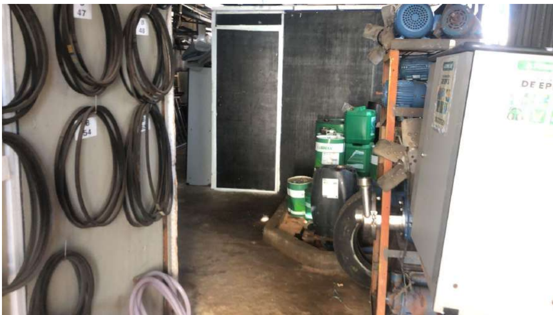
Foto 091: Setor de Manutenção
