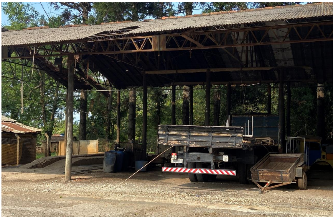
Foto 015: Setor de manutenção em geral
