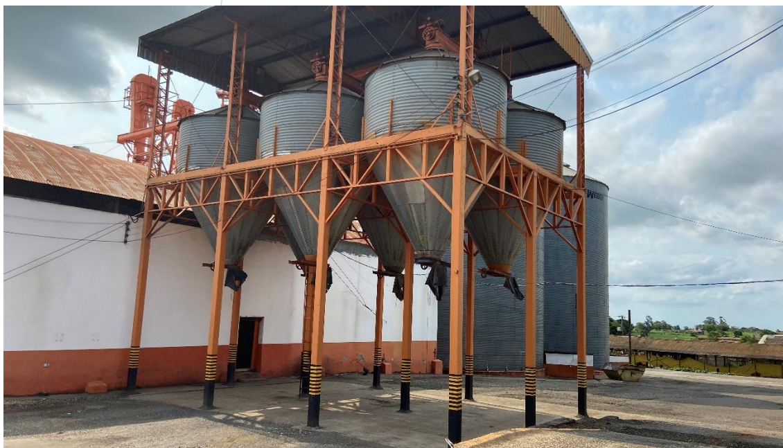
Foto 008: Silos de abastecimento
