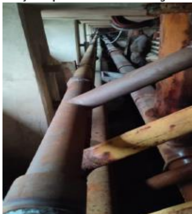
3) Reparo na tubulação de oxigênio
