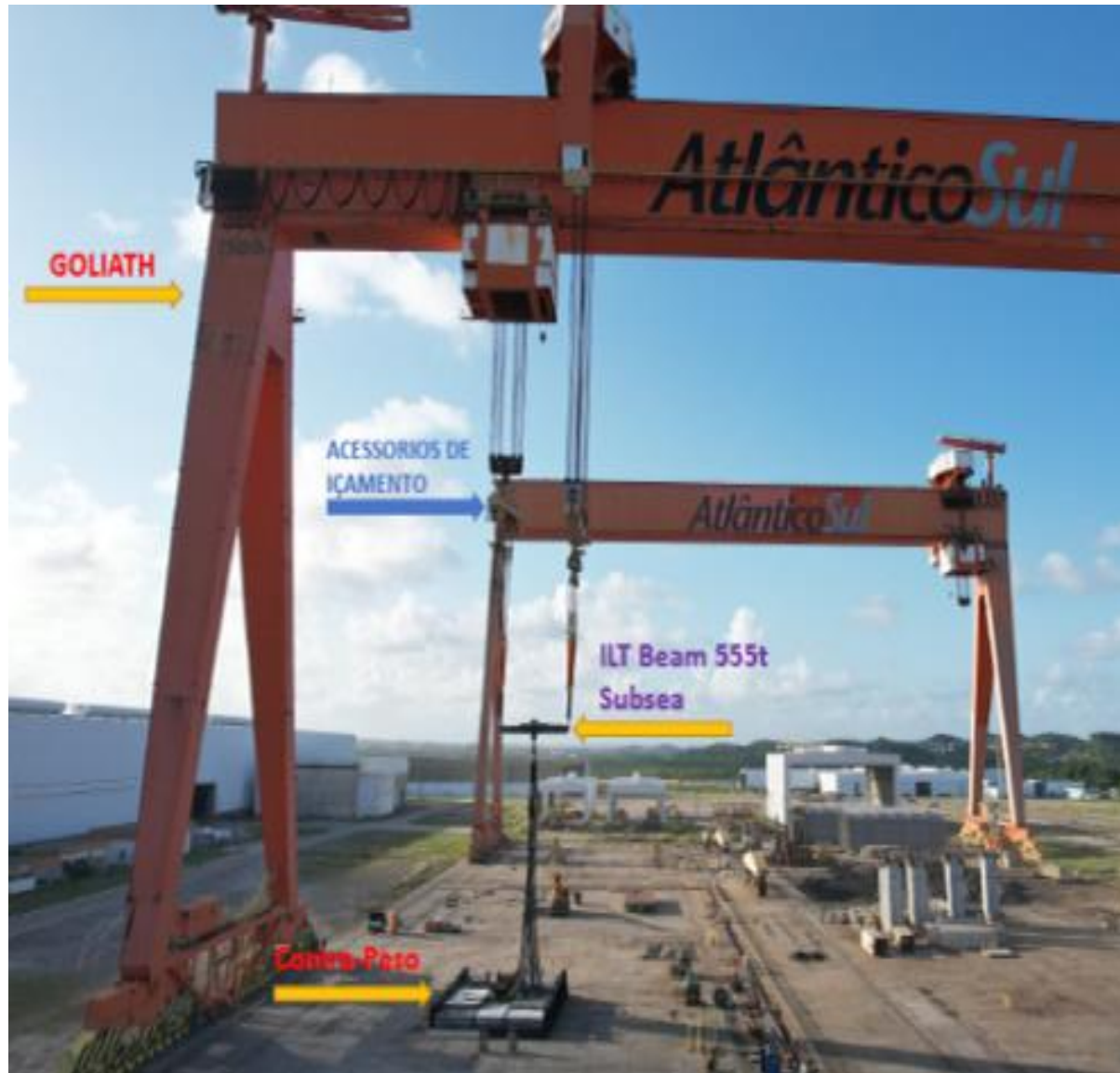
Estrutura metálica ILT BEAM - Subsea
