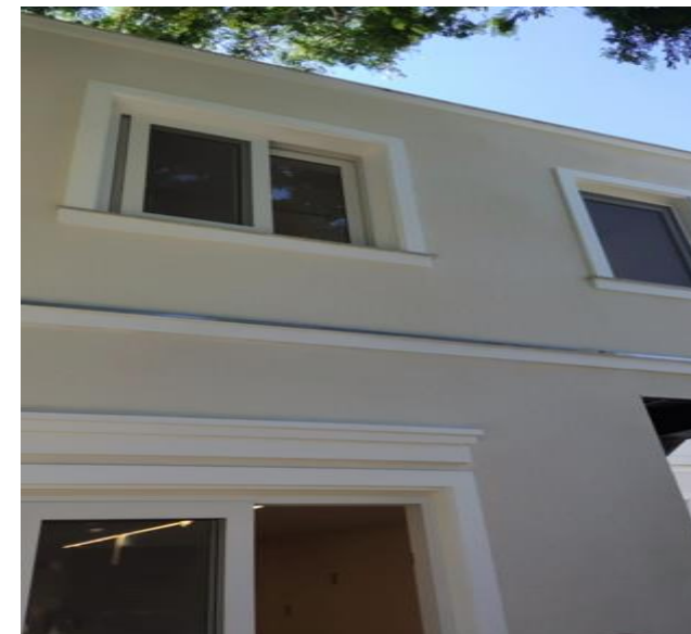
Serviço em execução para Torre de Pedra Empreendimentos
