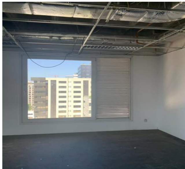
Serviço em execução na Avenida Carlos Gomes
