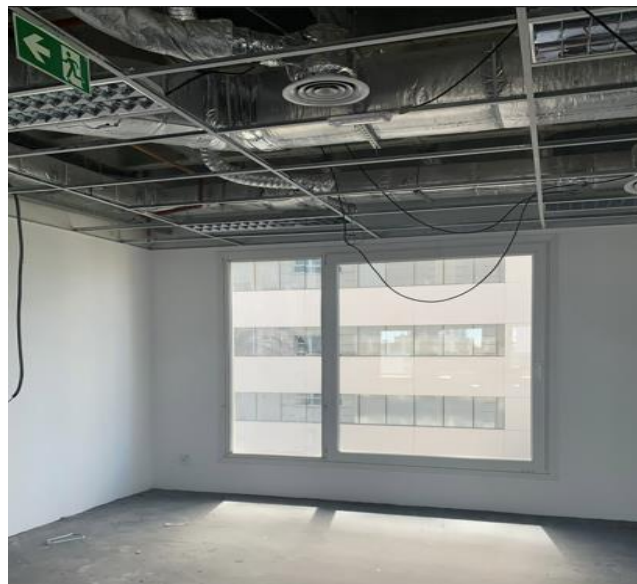
Serviço em execução na Avenida Carlos Gomes
