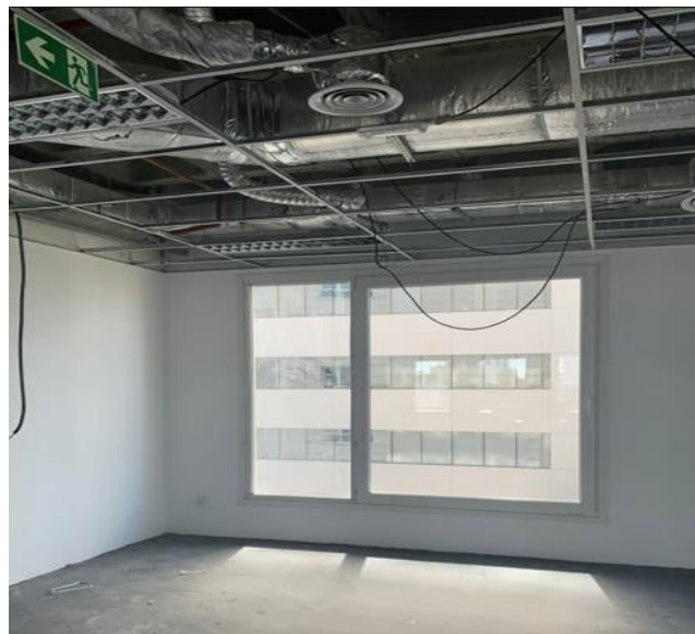
Serviço em execução na Avenida Carlos Gomes
