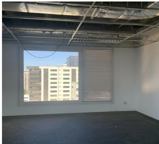
Serviço em execução na Avenida Carlos Gomes
