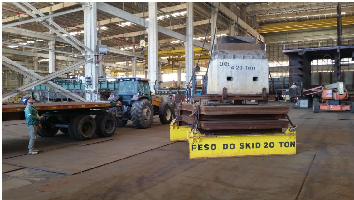
Manutenção Pontes Rolantes – Teste de Carga
