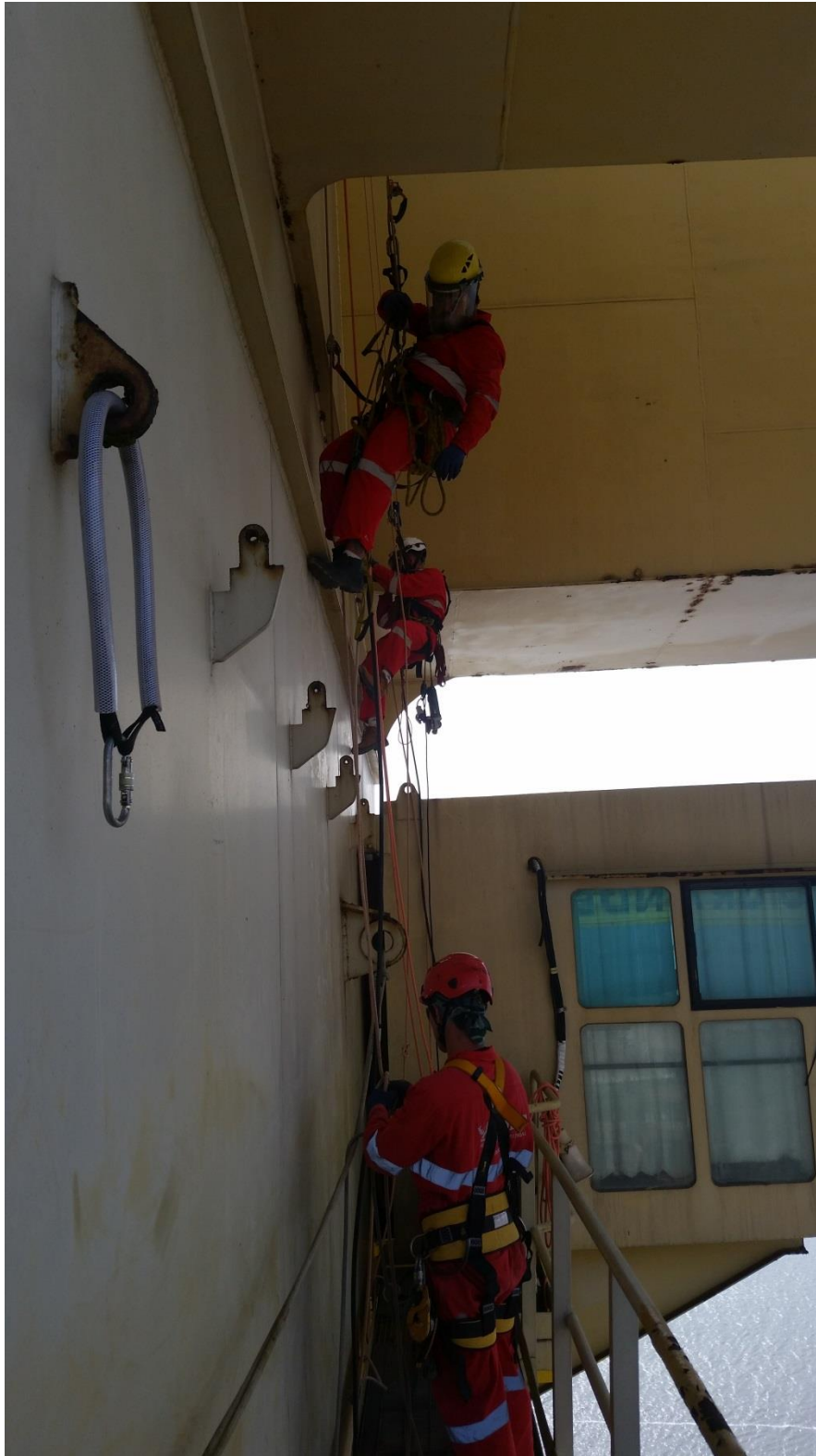
Serviço de alpinismo – tratamento pintura pórtico 600 ton
