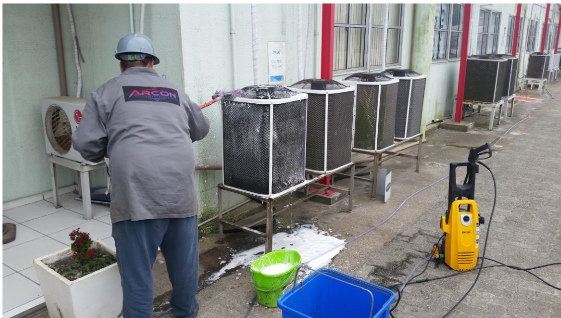
Manutenção e Limpeza Ar Condicionado
