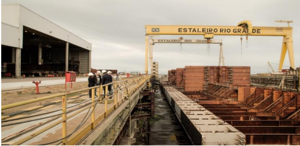
P-71 NO DIQUE
