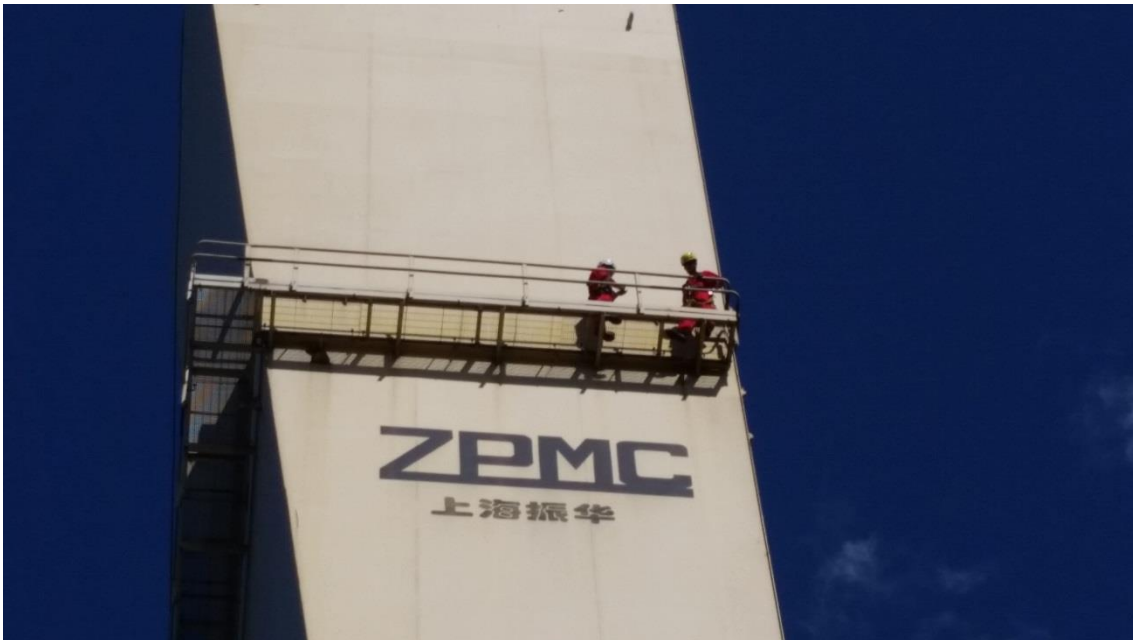
Serviço de alpinismo – tratamento pintura pórtico 600 ton
