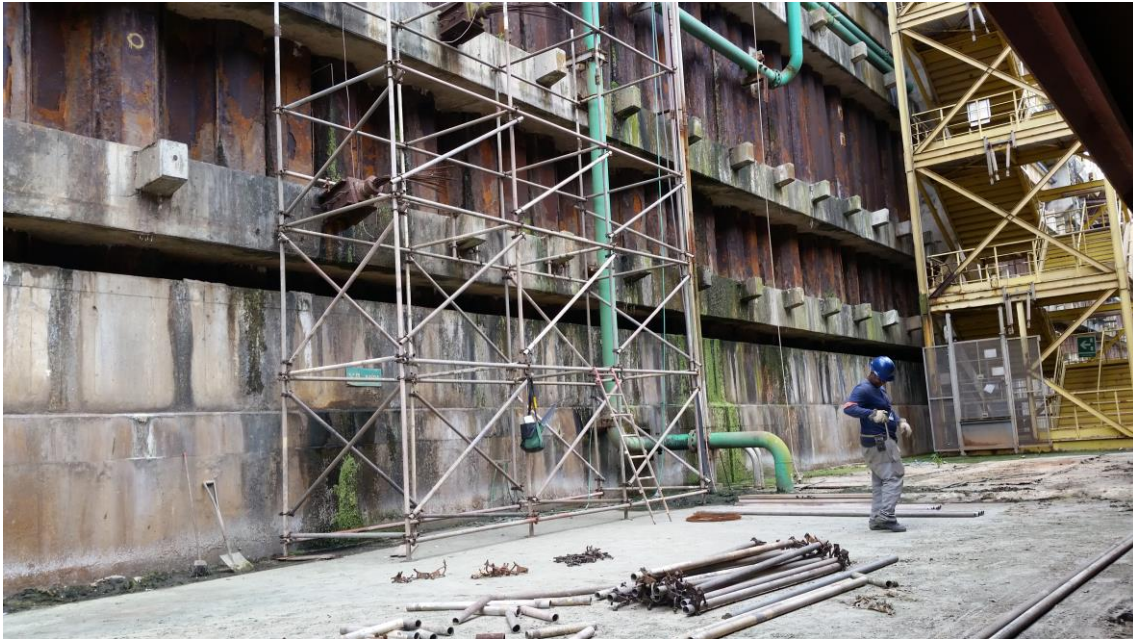
Manutenção Dique – instalação de chapa
