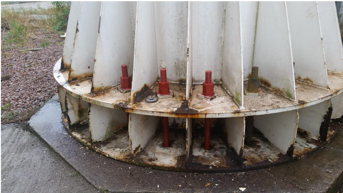
Tratamento e pintura bases taças de água potável
