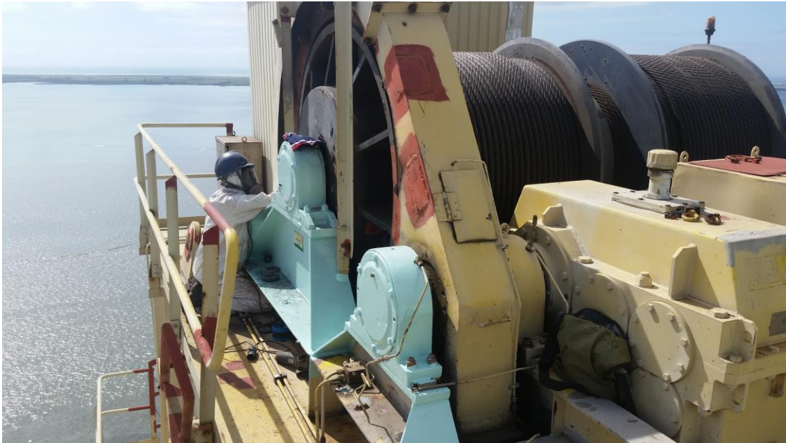
Tratamento e pintura pórtico 600 ton
