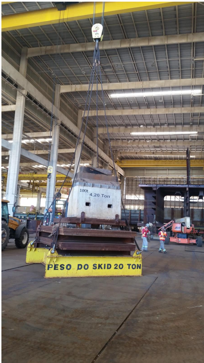
Manutenção Pontes Rolantes – Teste de Carga
