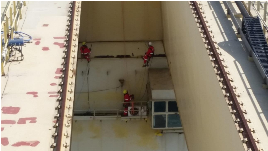
Serviço de alpinismo – tratamento pintura pórtico 600 ton
