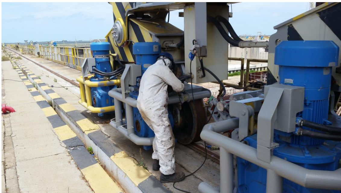
Tratamento e pintura pórtico 600 ton
