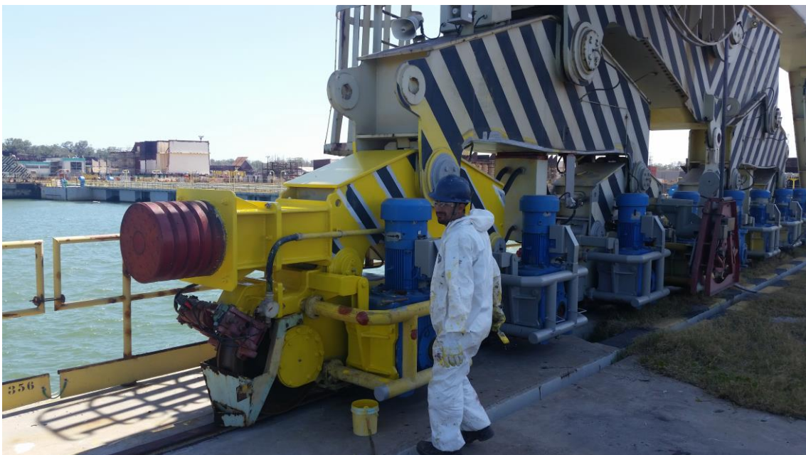
Tratamento e pintura pórtico 600 ton
