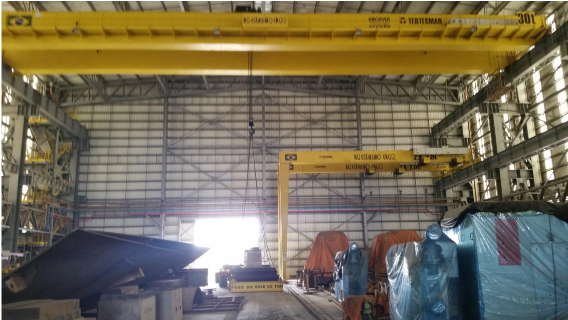
Teste de carga Pontes Oficinas Erg 2
