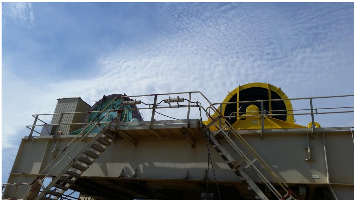
Tratamento e pintura Pórtico 600 ton
