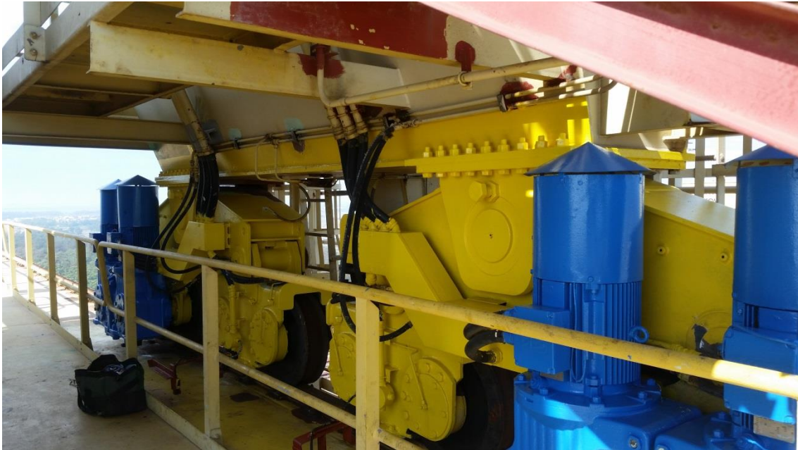
Tratamento e pintura Pórtico 600 ton
