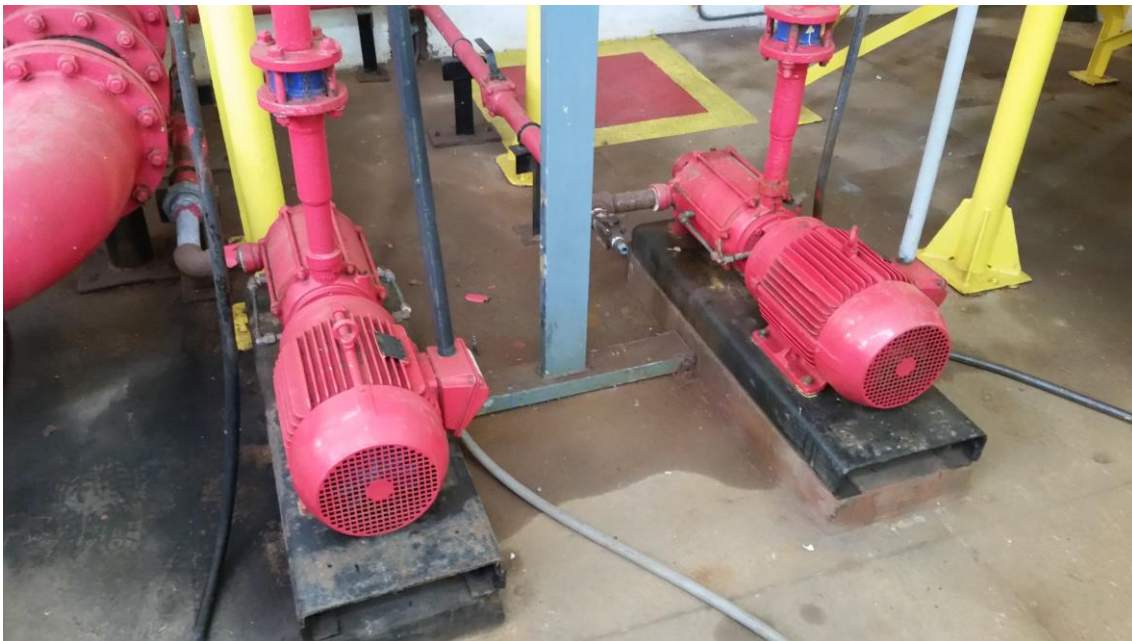
Manutenção Sistema de Combate à Incêndio
