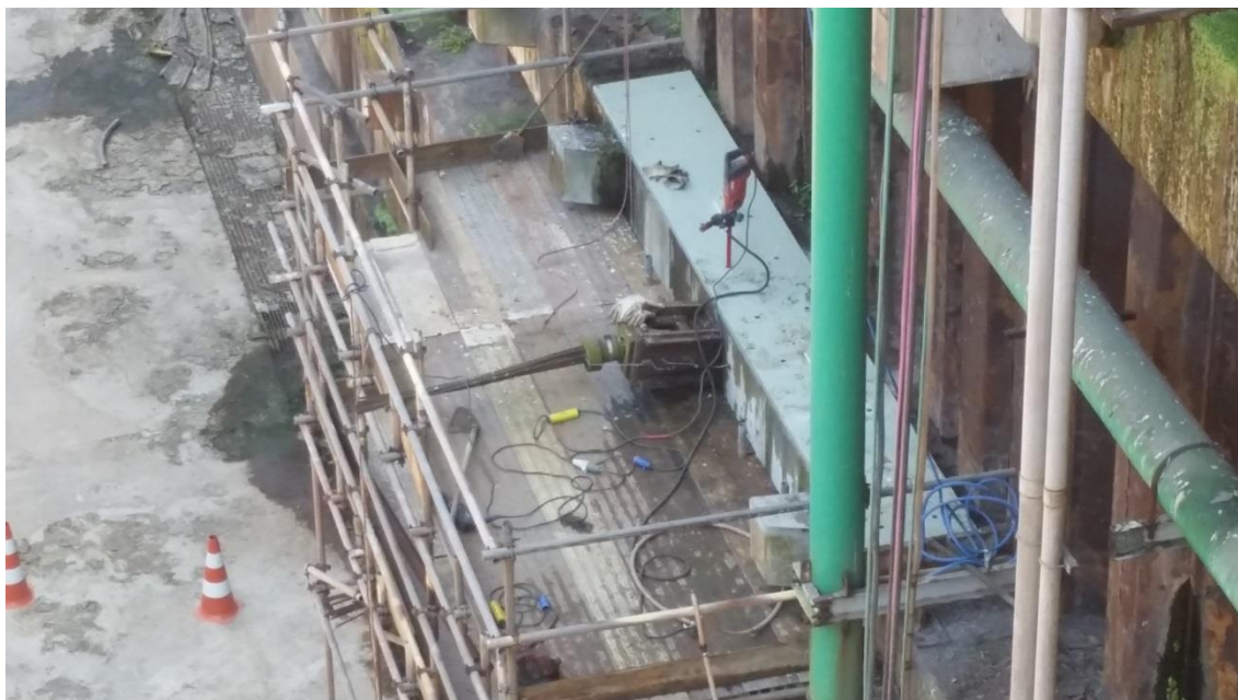
Manutenção Dique Seco – fixação de reforço estrutural
