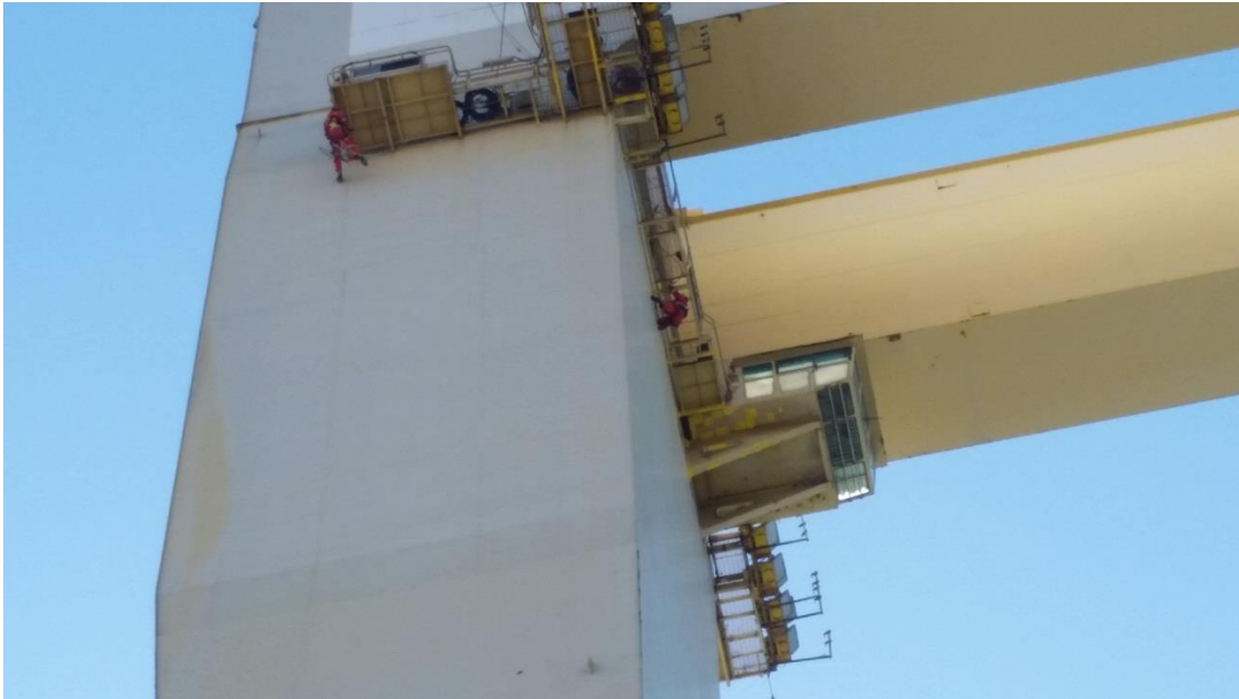
Serviço de alpinismo – tratamento pintura pórtico 600 ton
