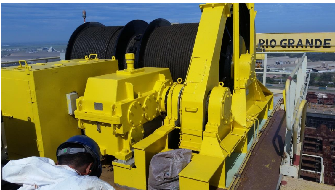
Tratamento e pintura Pórtico 600 ton
