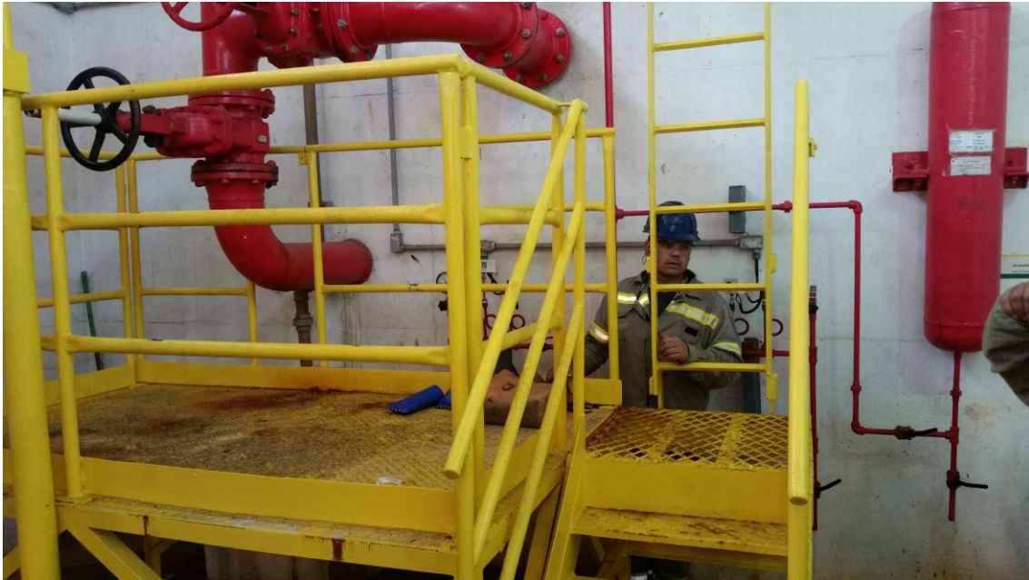
Manutenção Sistema de Combate à Incêndio
