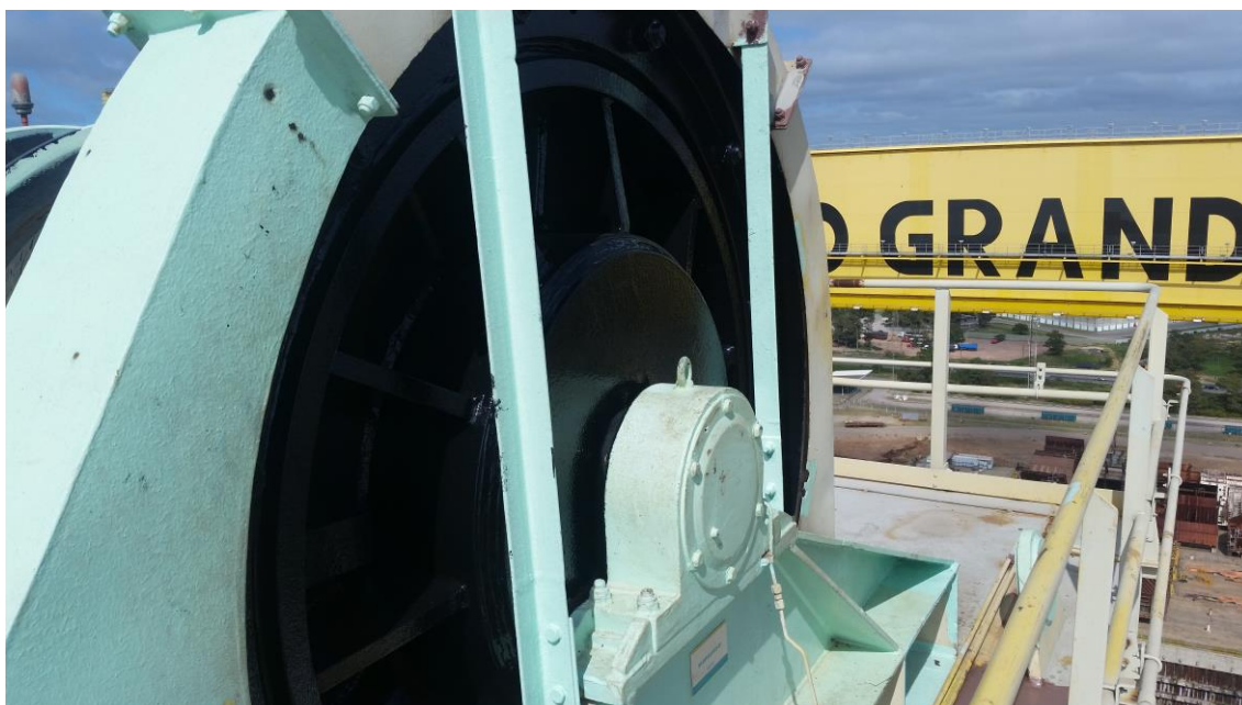
Tratamento e pintura pórtico 600 ton
