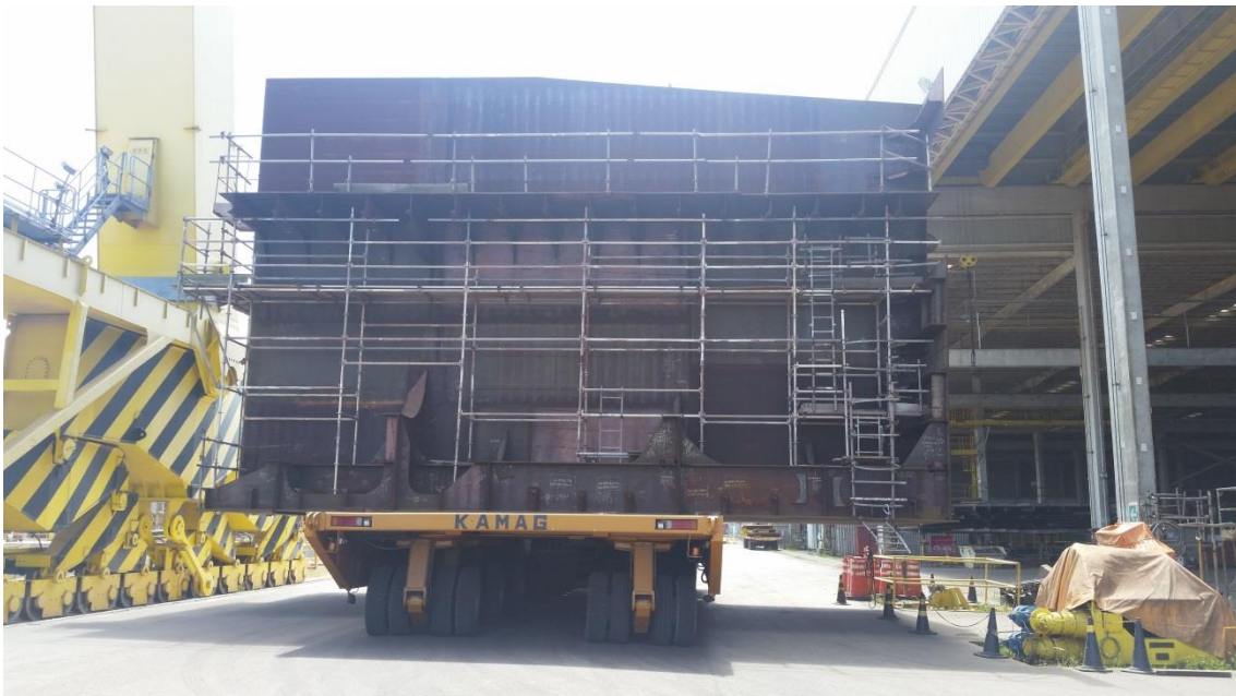
Movimentação de blocos P-72
