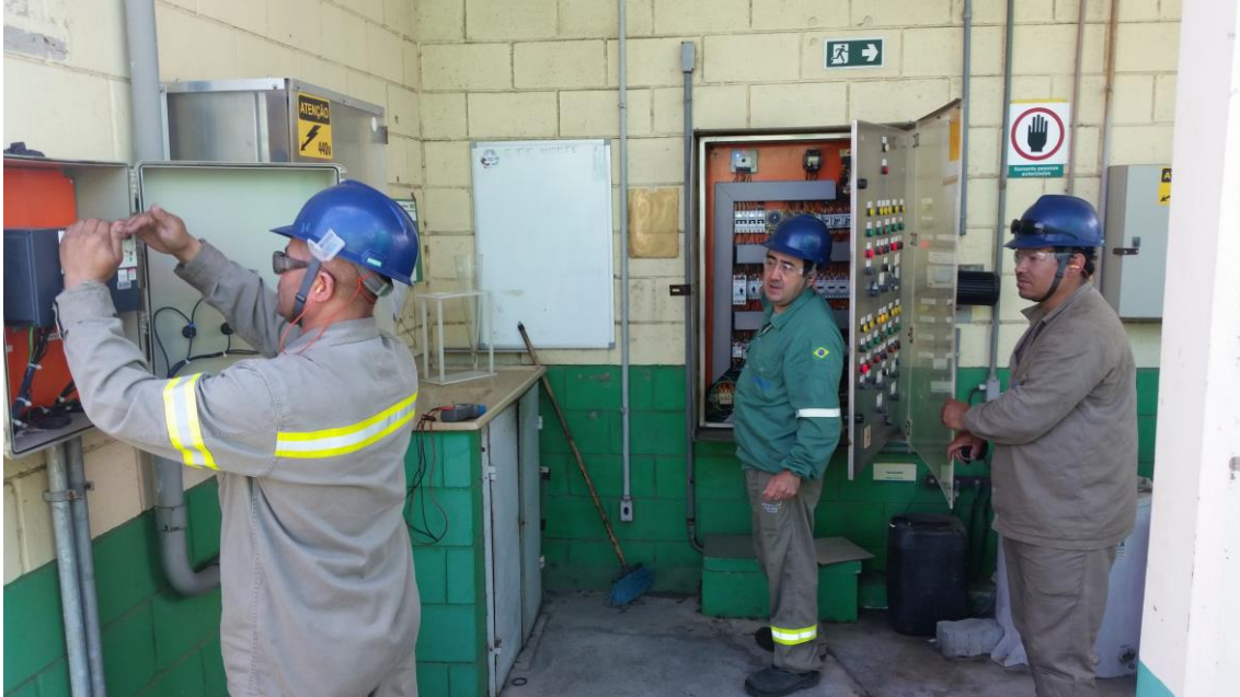
Manutenção Estação de Tratamento de Esgoto
