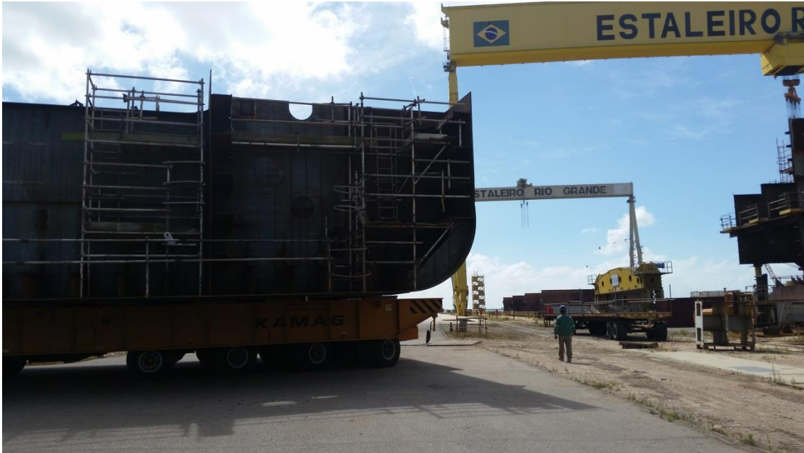
Movimentação de blocos P-72
