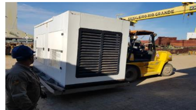
Manutenção Geradores de Emergência
