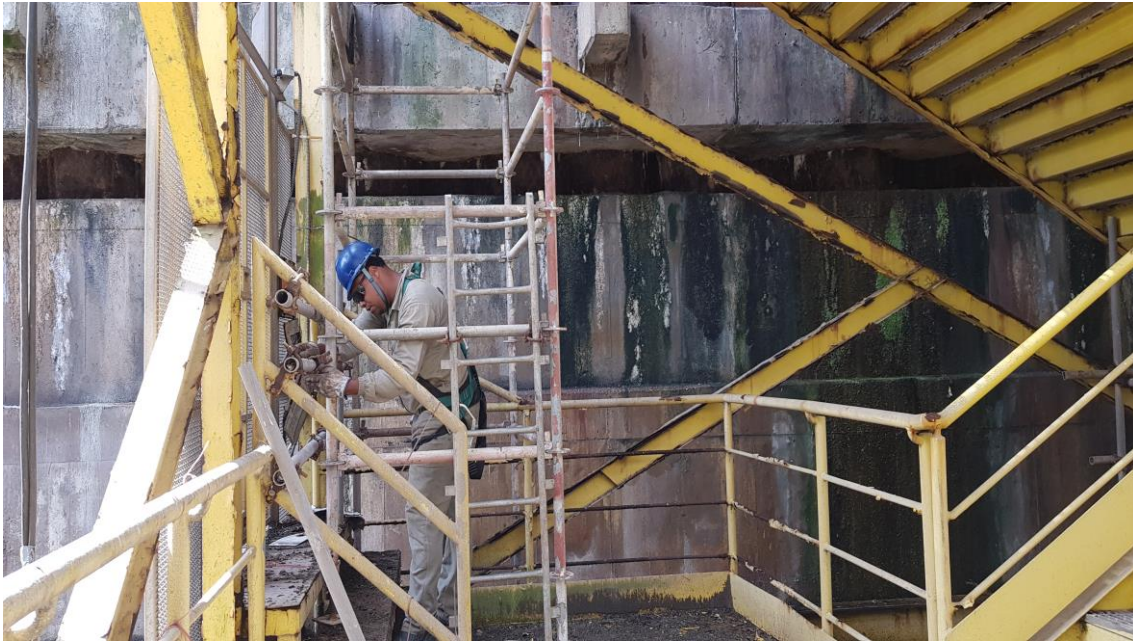
Manutenção Escadas de Acesso
