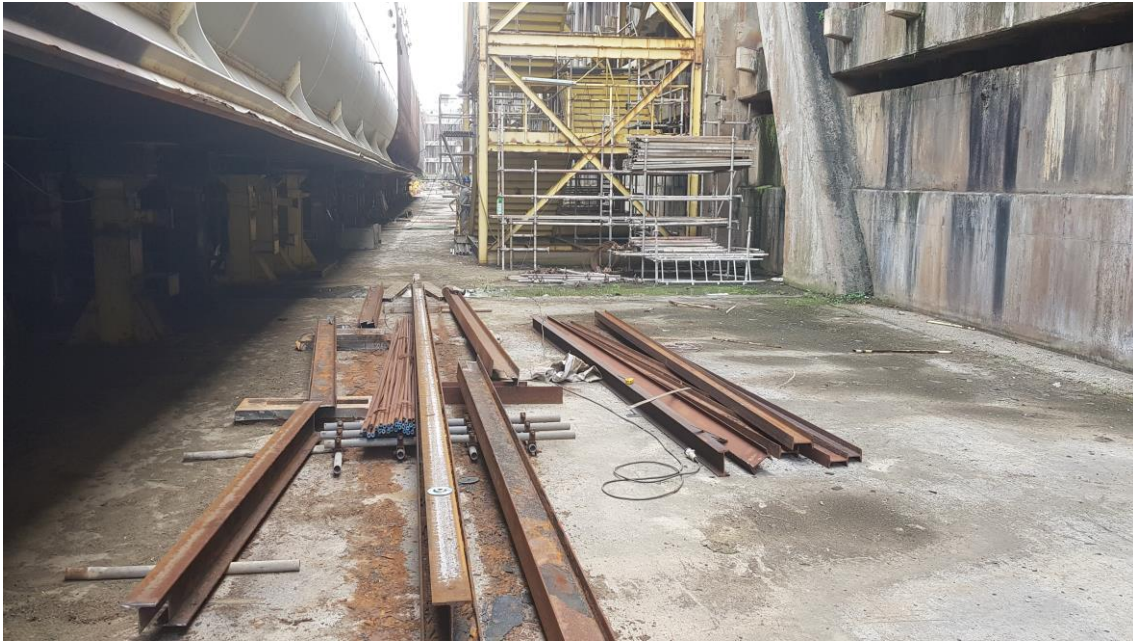
Manutenção Escadas de Acesso
