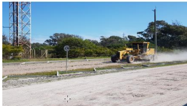
Manutenção Acessos Estaleiro
