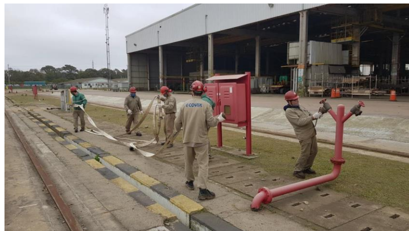
Manutenção e Testes – Sistema de Combate Incêndio
