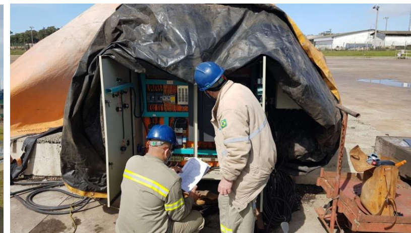
Manutenção Guinchos de MAnobra
