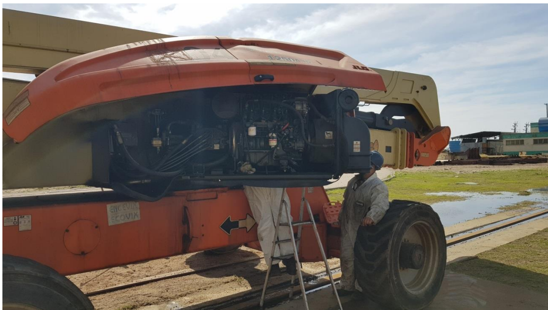
Manutenção Equipamentos – PTA
