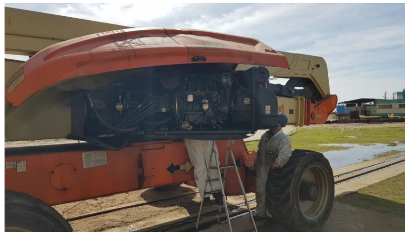
Manutenção Equipamentos - PTA
