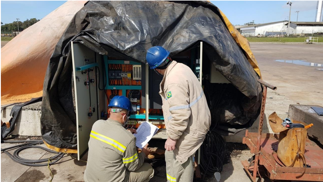
Manutenção Guinchos de Manobra
