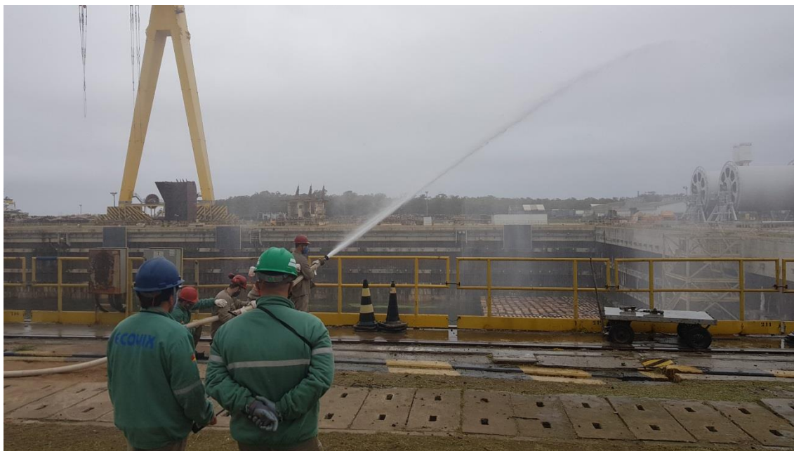
Manutenção e Testes – Sistema de Combate Incêndio
