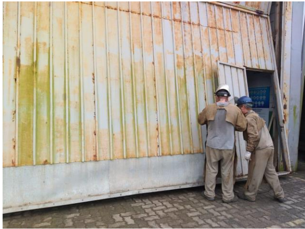
Manutenção Portão infraestrutura
