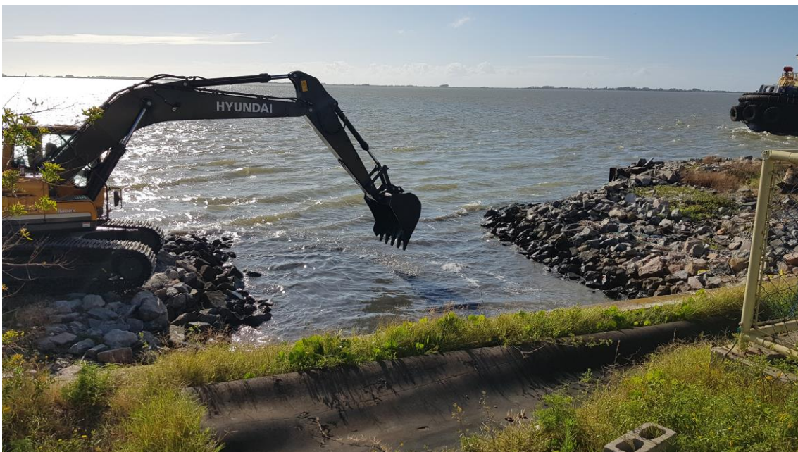
Manutenção entrada do sistema de captação de água Sistema de Combate a Incêndio
