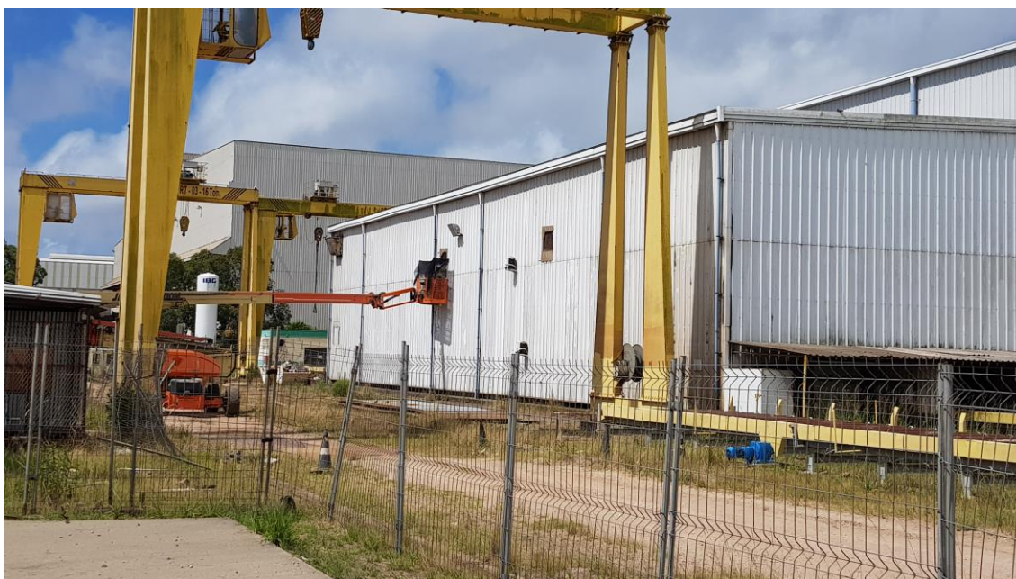
Instalação de proteção contra pombos – Shotblasting
