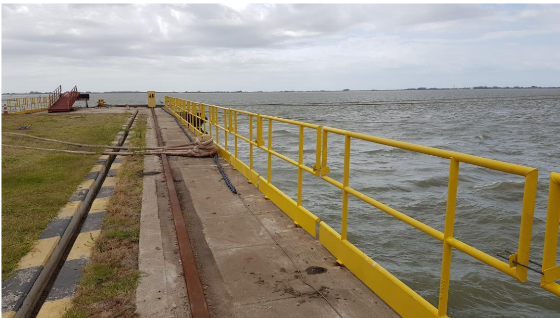
Manutenção guarda corpo
