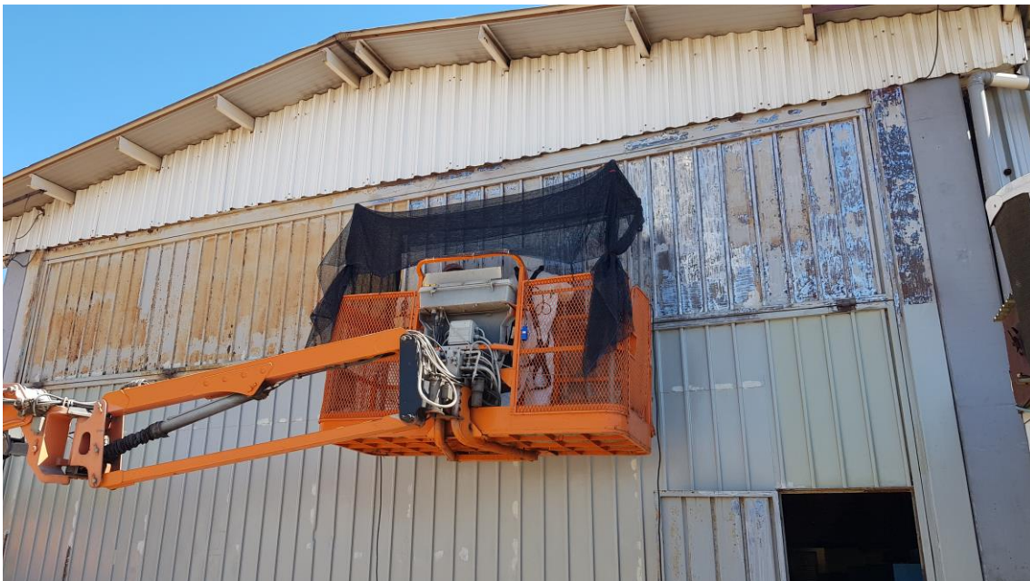
Manutenção portão infraestrutura
