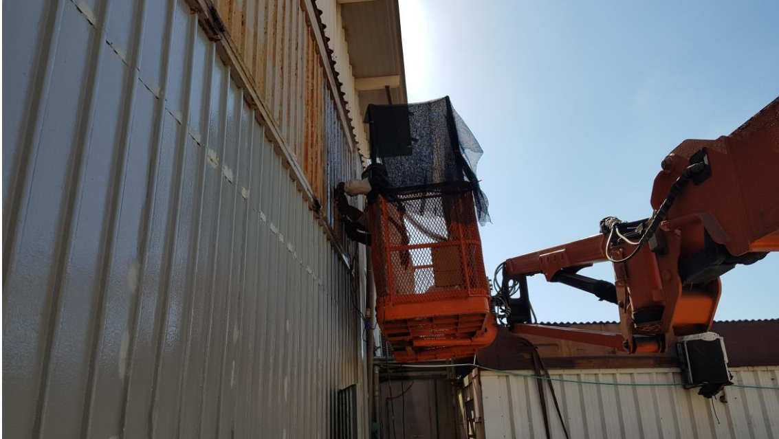
Manutenção portão infraestrutura
