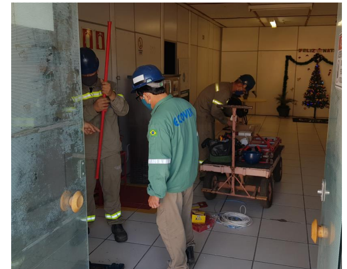
Execução de PPCI
