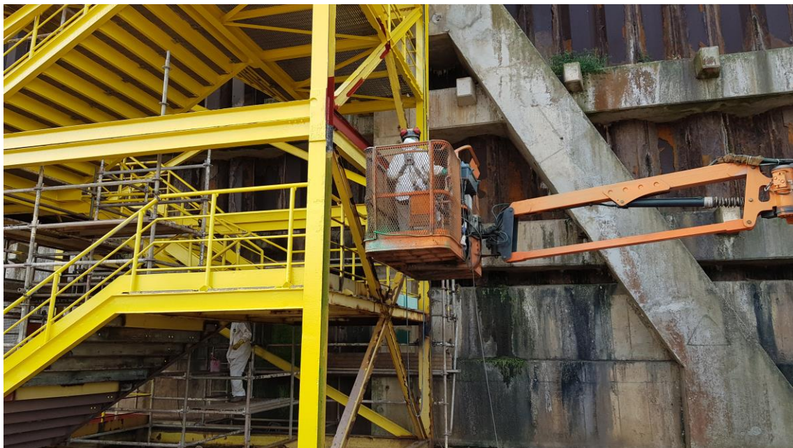
Manutenção escada de acesso
