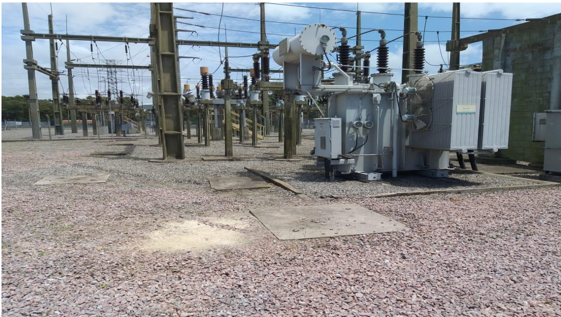
Capina – corte de grama - Subestação principal
