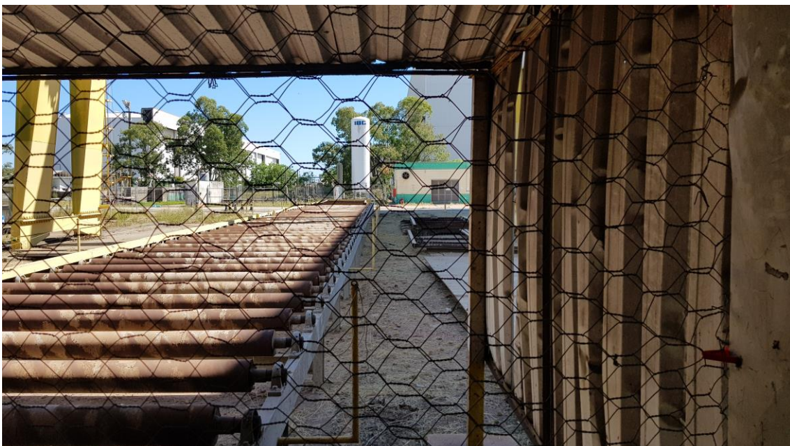
Instalação de proteção contra pombos – Shotblasting
