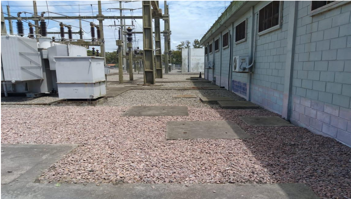
Capina – corte de grama - Subestação principal
