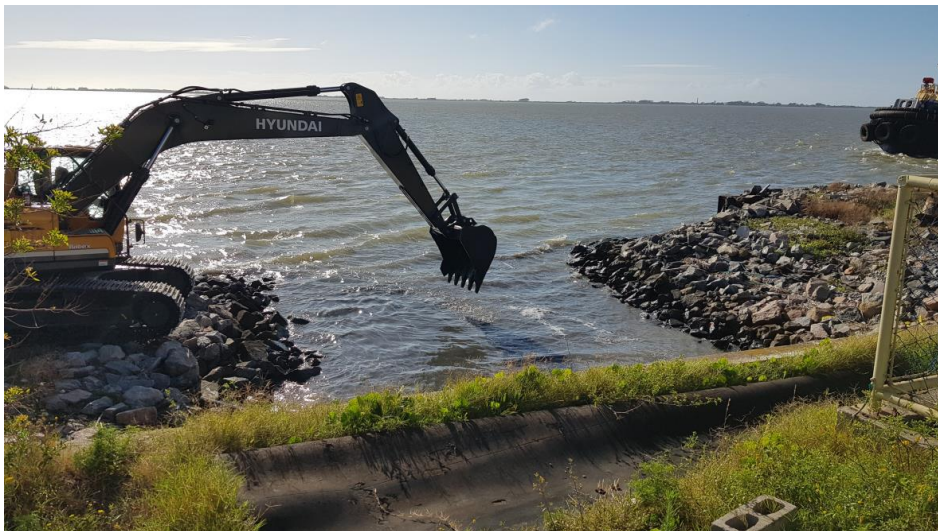
Manutenção entrada do sistema de captação de água
