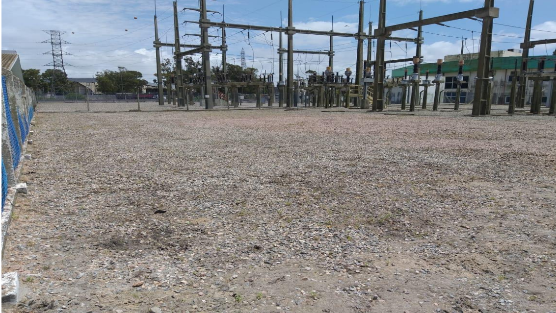
Capina – corte de grama - Subestação principal
