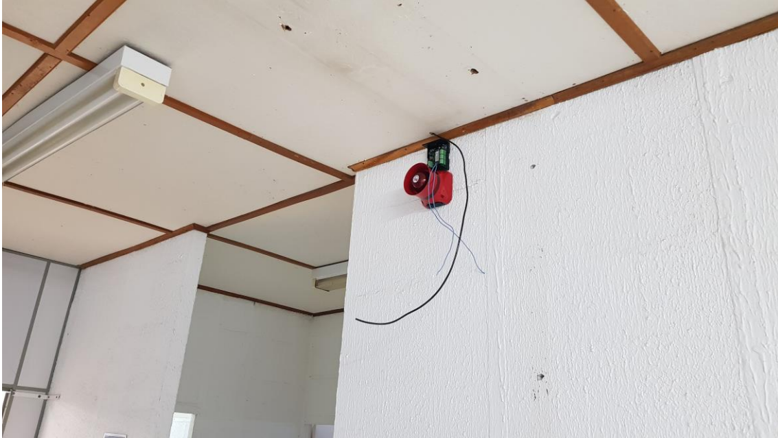
PPCI – Plano de Prevenção e Proteção Contra Incêndios Instalação de alarmes
