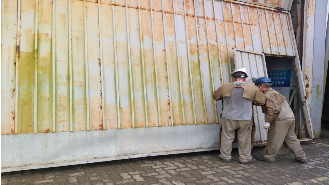
Manutenção portão infraestrutura
