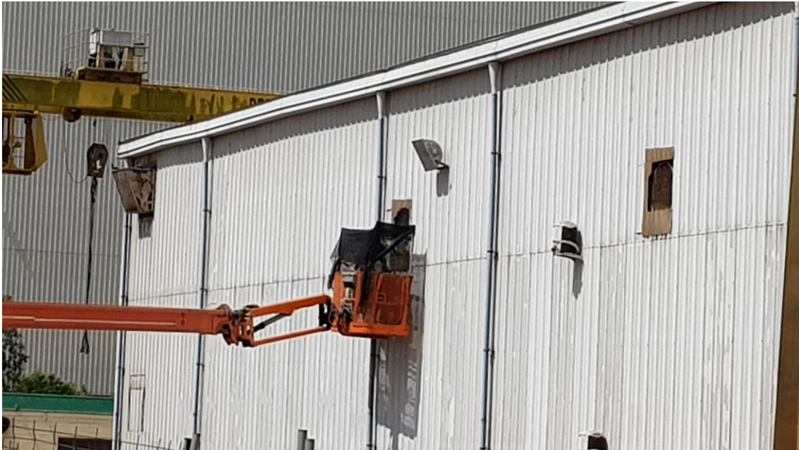
Instalação de proteção contra pombos – Shotblasting
