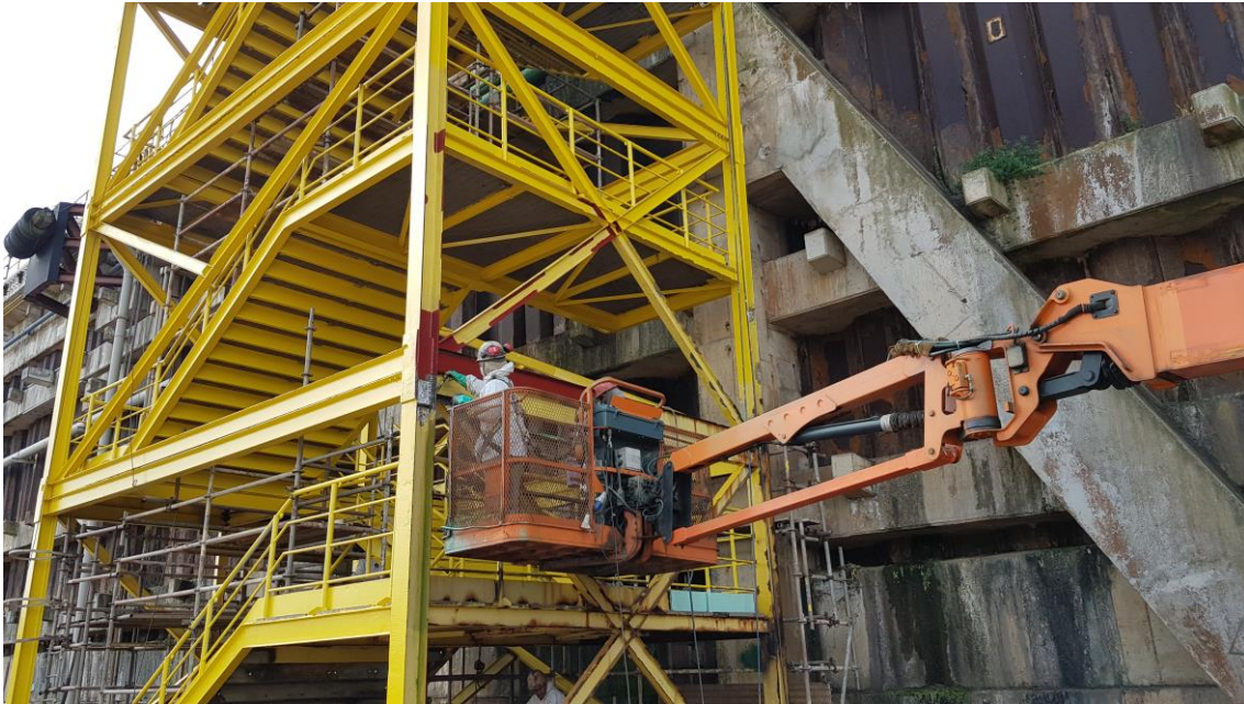
Manutenção escada de acesso
