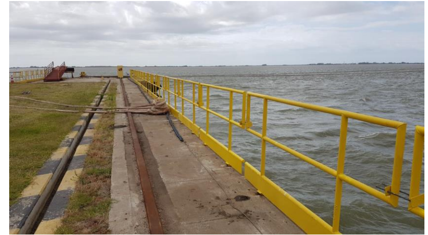
Manutenção Guarda Corpo
