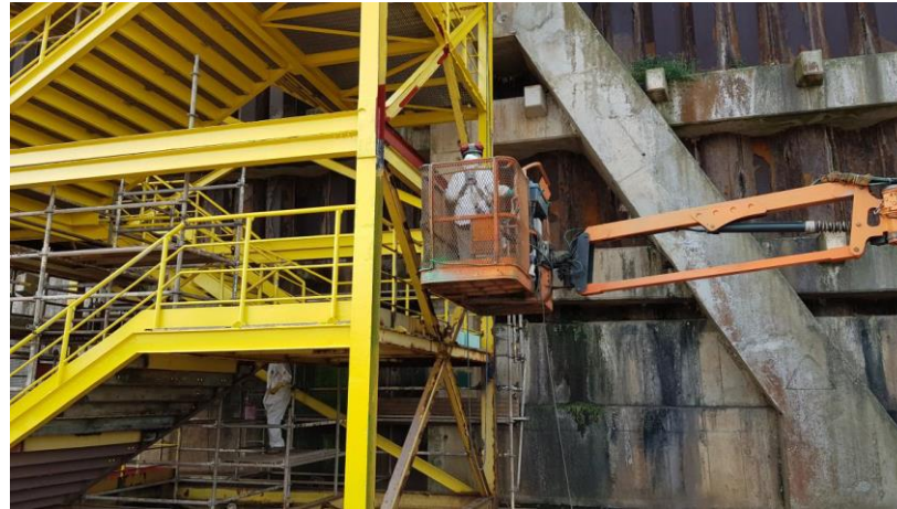
Manutenção Escadas de Acesso
