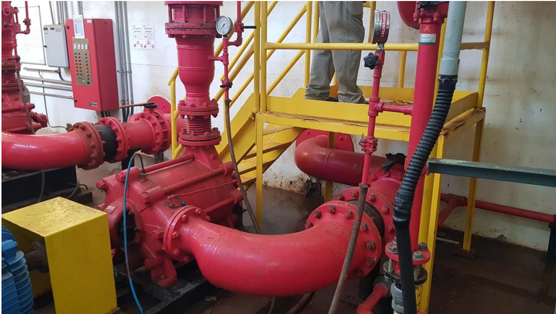
Manutenção Estruturas e Equipamentos
