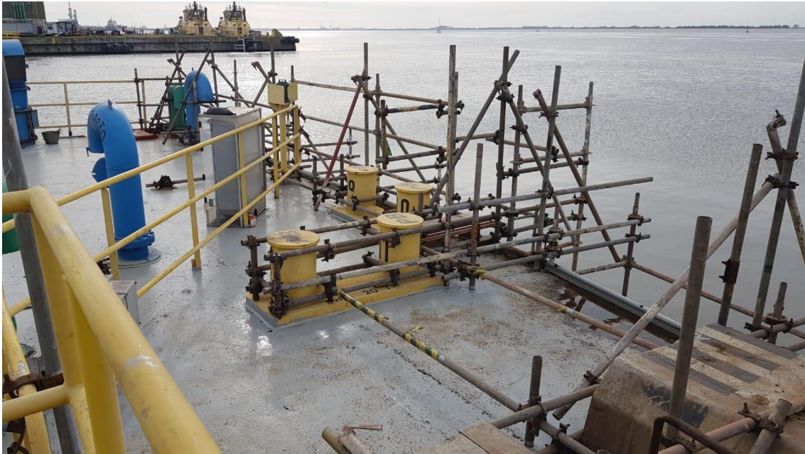
Manutenção Estruturas e Equipamentos
