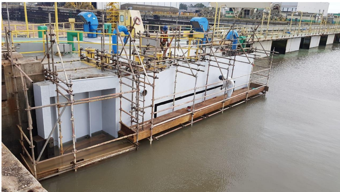
Manutenção Estruturas e Equipamentos
