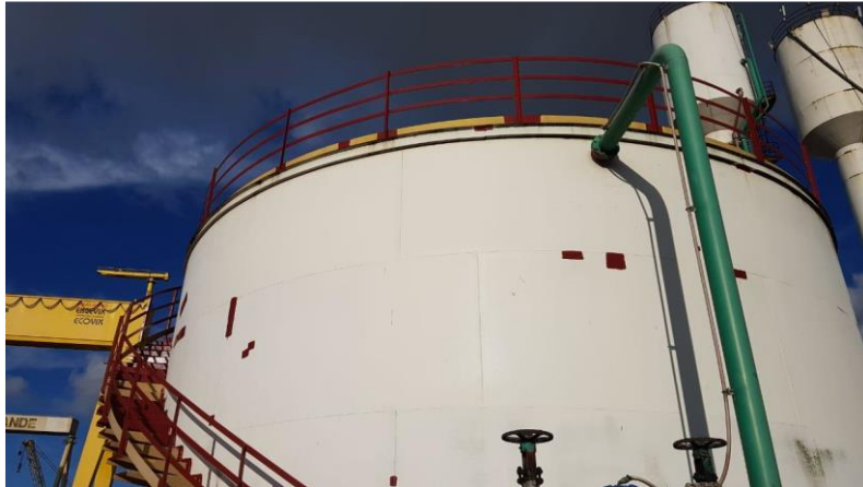
Manutenção Estruturas e Equipamentos
