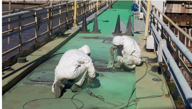
Manutenção Estruturas e Equipamentos
