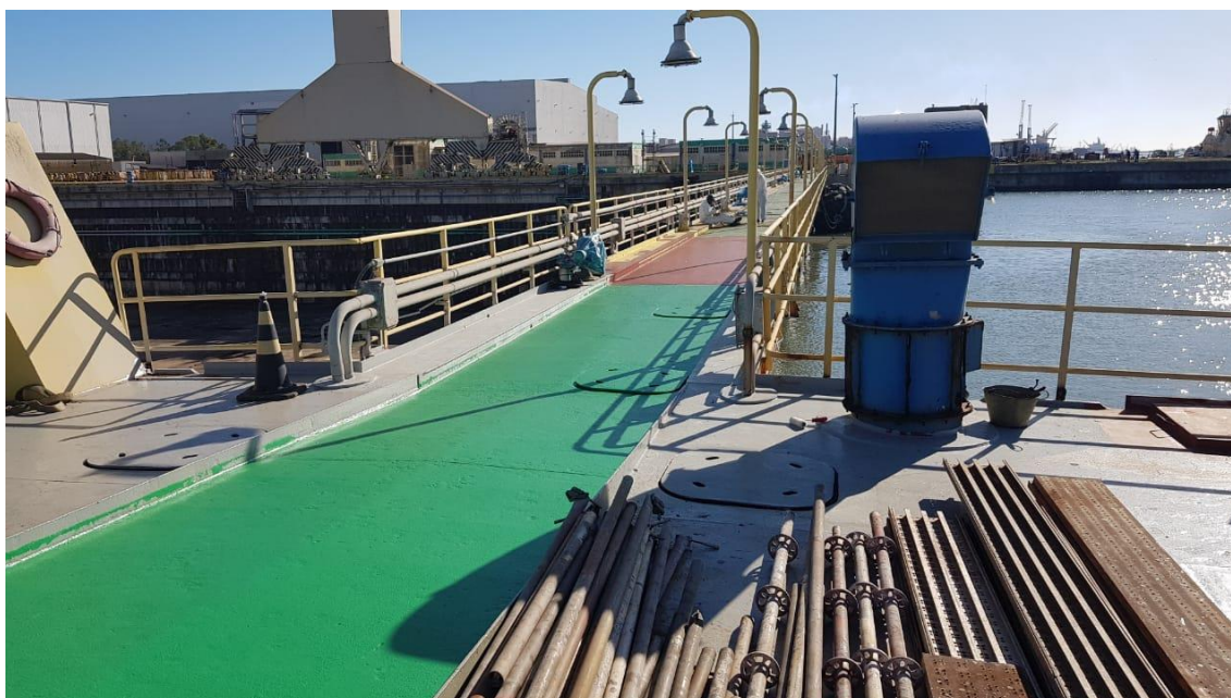
Manutenção Estruturas e Equipamentos
