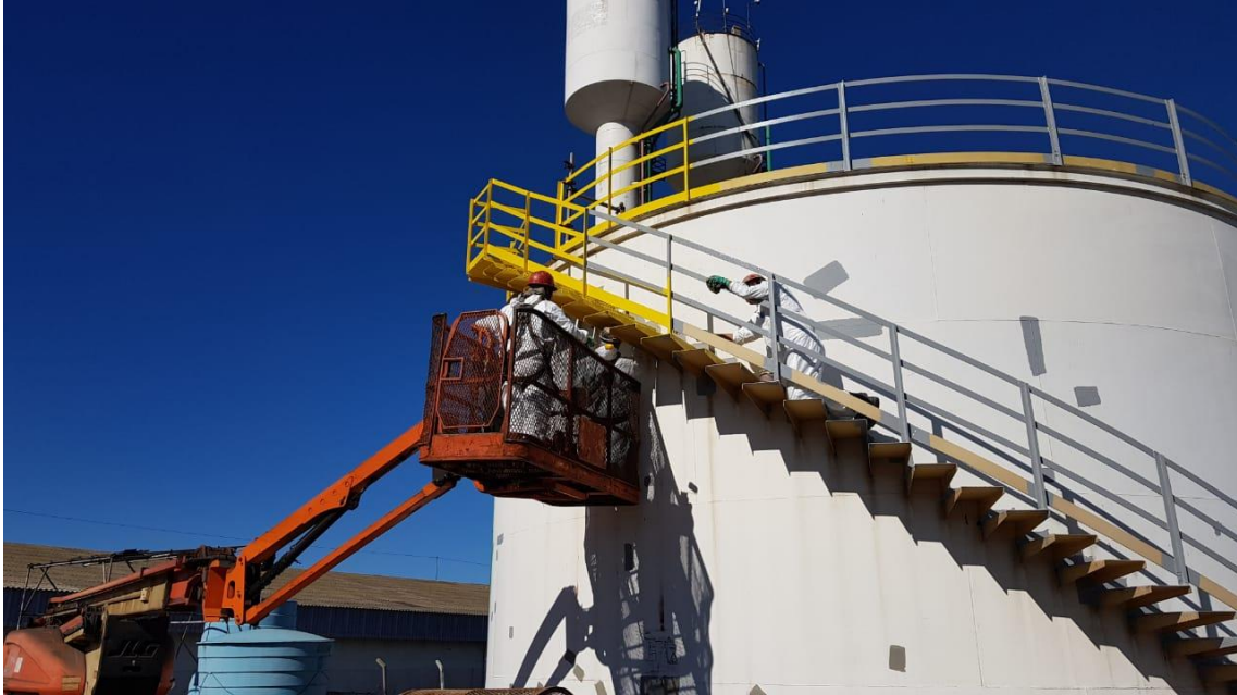
Manutenção Estruturas e Equipamentos
