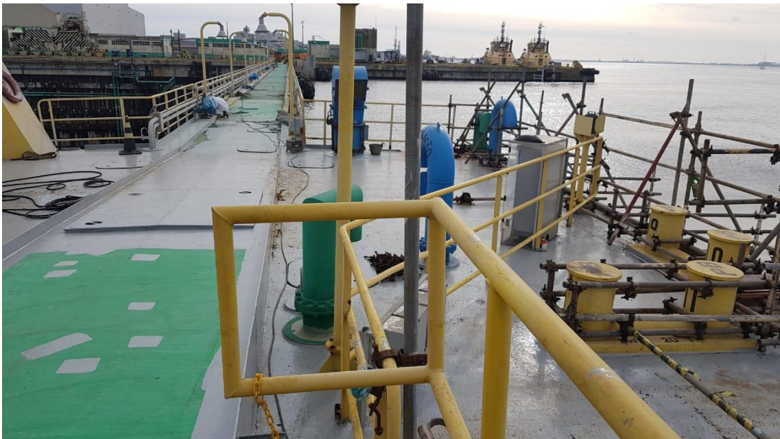
Manutenção Estruturas e Equipamentos
