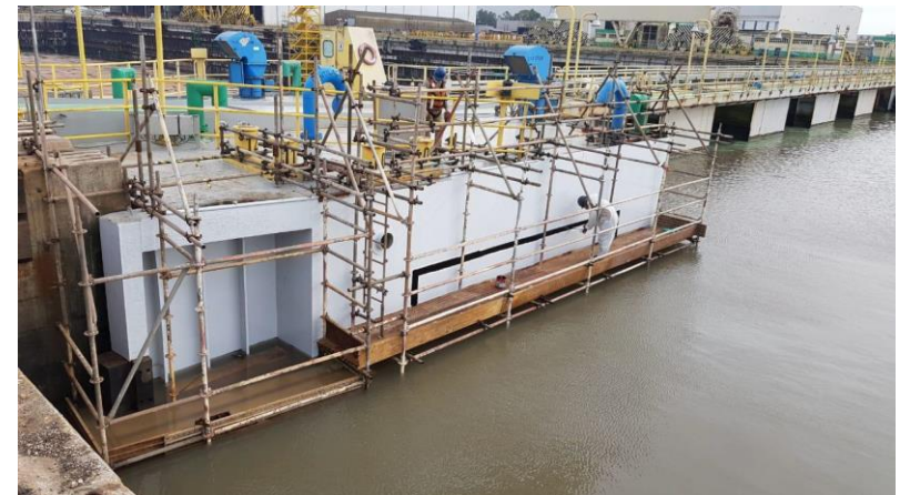
Manutenção Estruturas e Equipamentos
