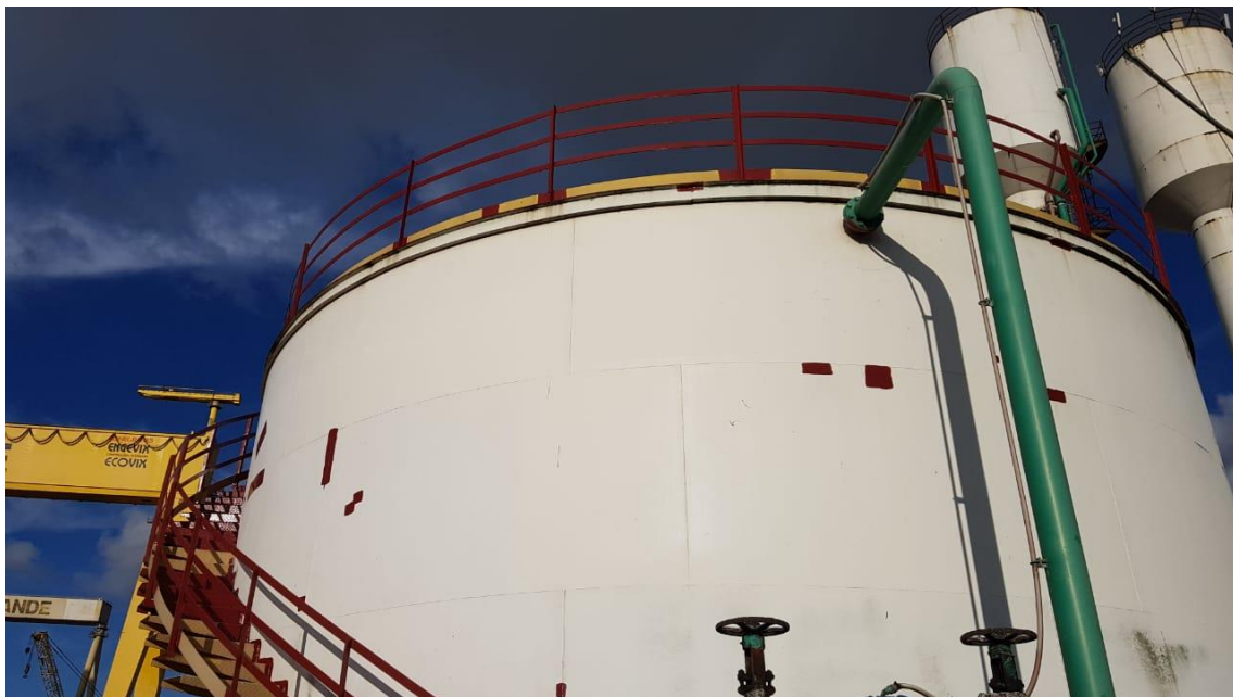
Manutenção Estruturas e Equipamentos
