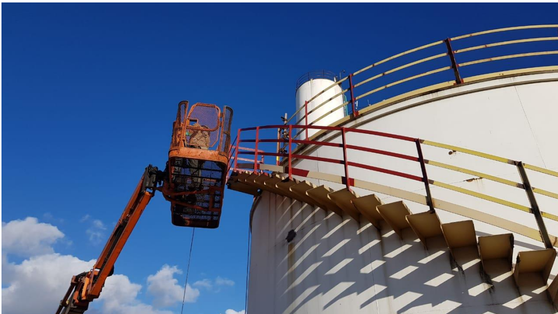
Manutenção Estruturas e Equipamentos
