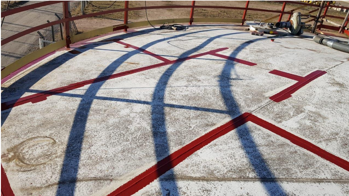
Manutenção Estruturas e Equipamentos
