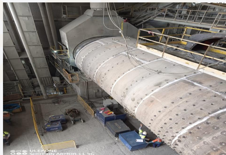
Obra CSN Cimentos
