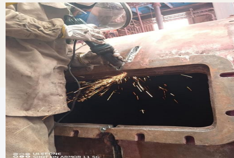
Obra Nexa Resources
