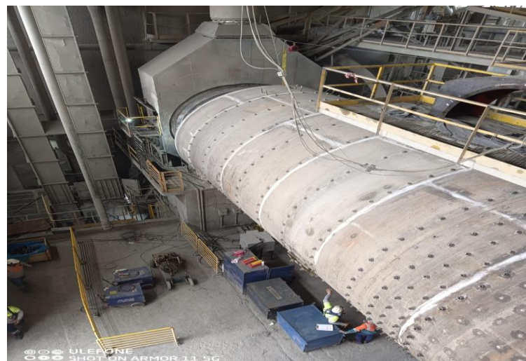
Obra CSN Cimentos
