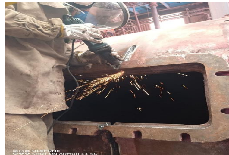
Obra Nexa Resources
