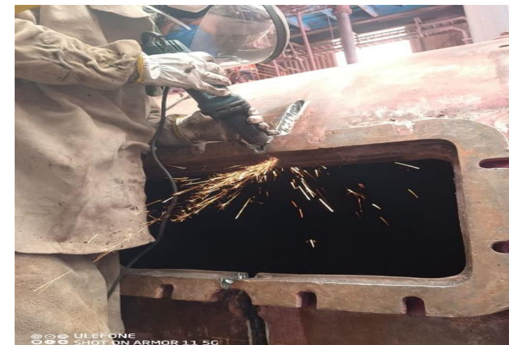
Obra Nexa Resources
