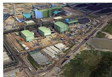
Thyssen Krupp / CSA Rio de Janeiro / RJ
