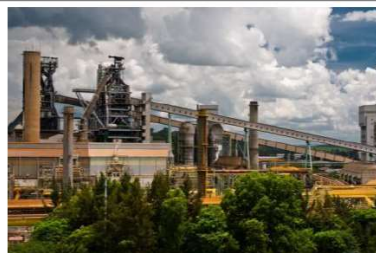
Gerdau Açominas Ouro Branco / MG
