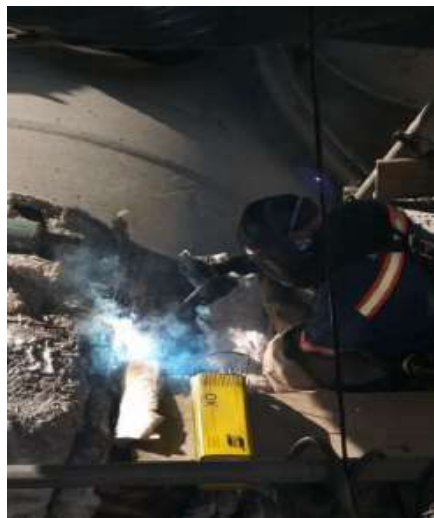
Vista da soldagem da trinca conforme procedimento
