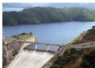
Central Hidroeléctrica de Monción República Dominicana
