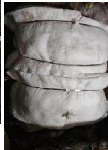
Pós-aquecimento da solda acabada
