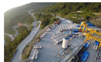
Central Hidrelétrica San Francisco Equador
