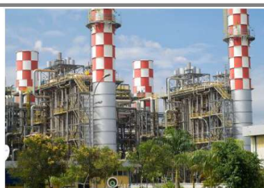
EDF Norte Fluminense Macaé / RJ
