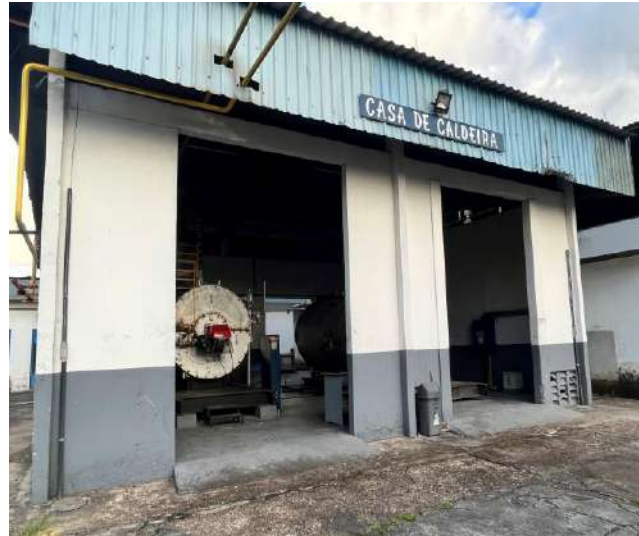
Casa de Caldeiras
