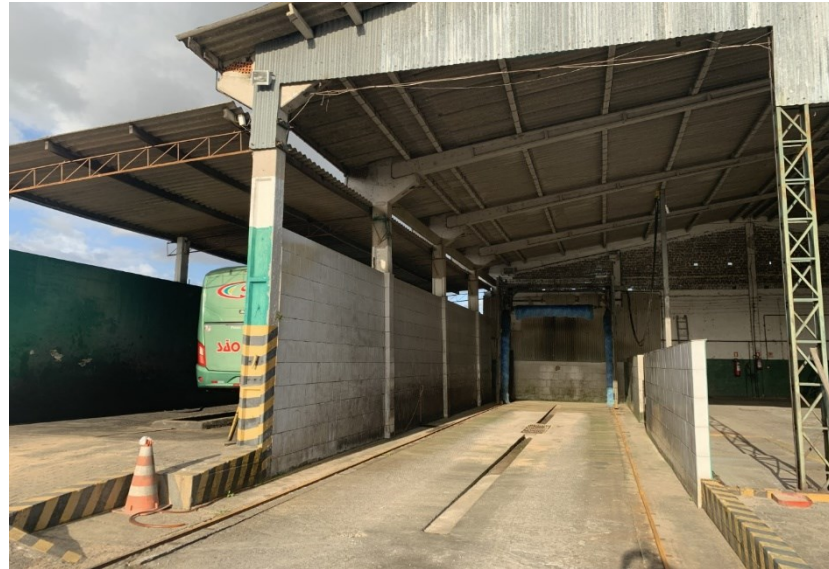
Rampa de Lavagem
