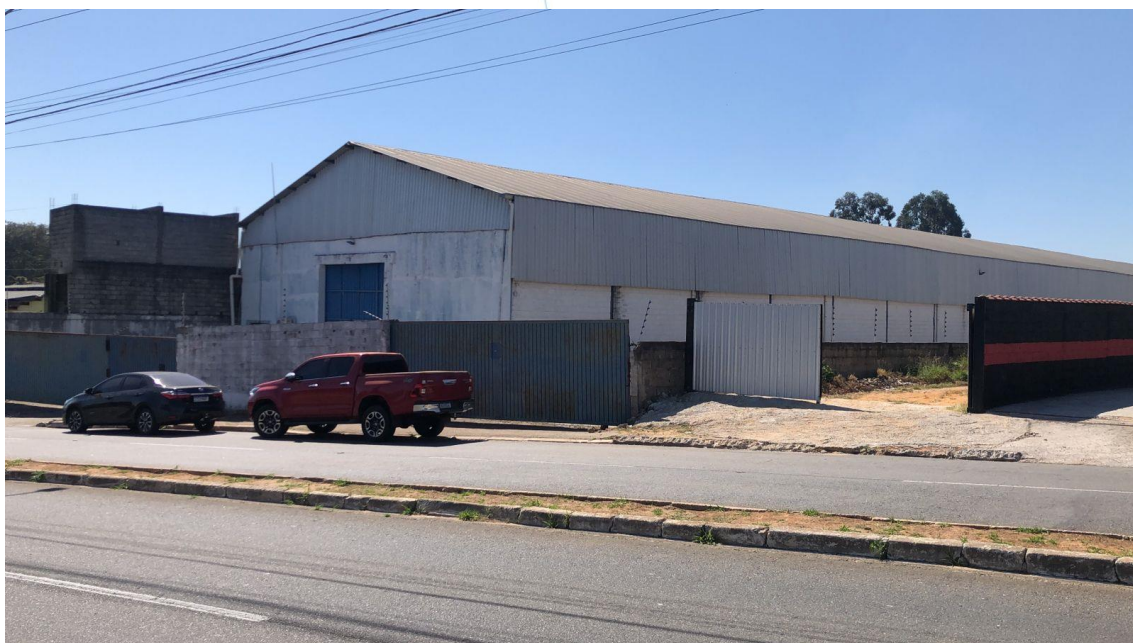
Foto 003: Vista lateral do galpão
