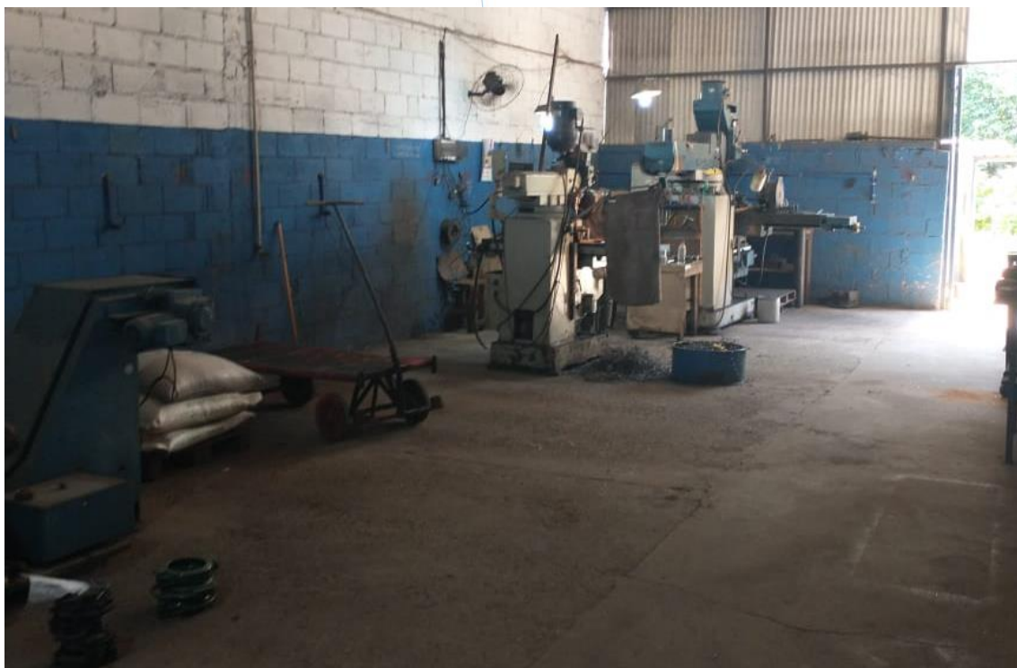
Foto 011: Setor de Soldagem
