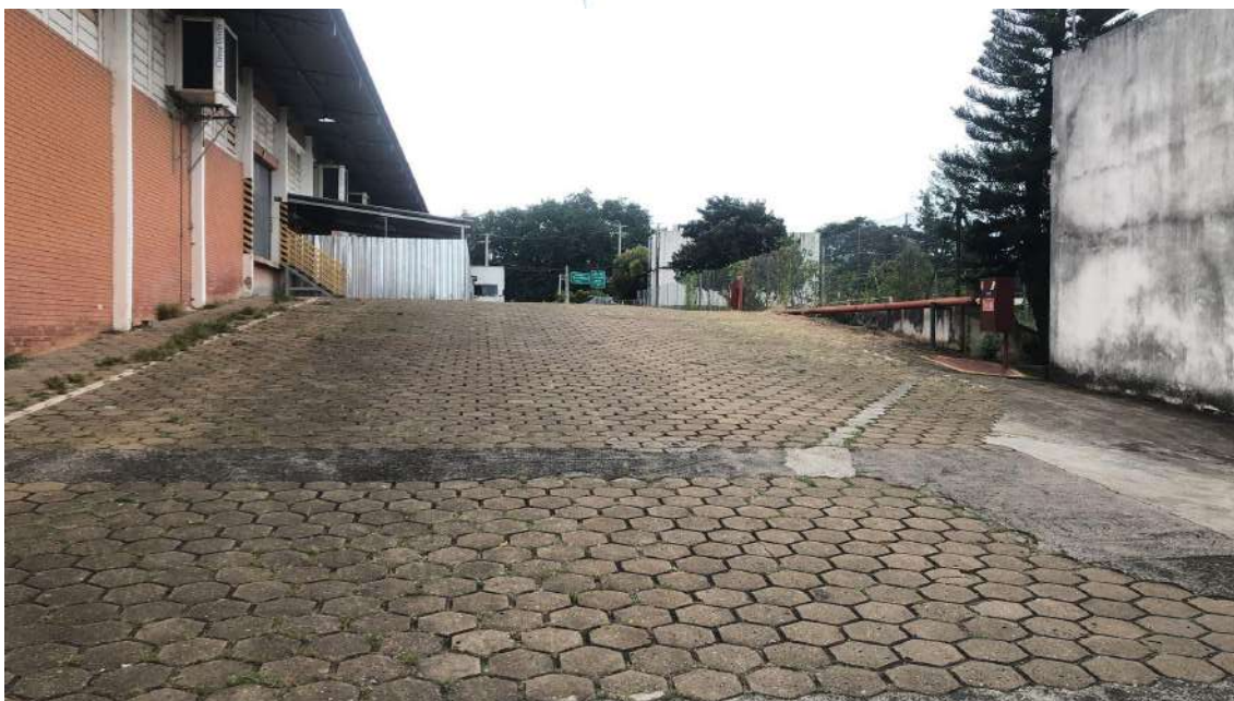
Foto 029: Passagem para manutenção
