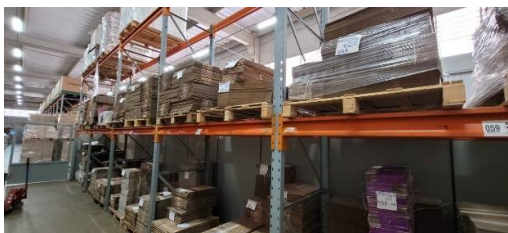
Figura 38 – Modulo de estrutura de aço
