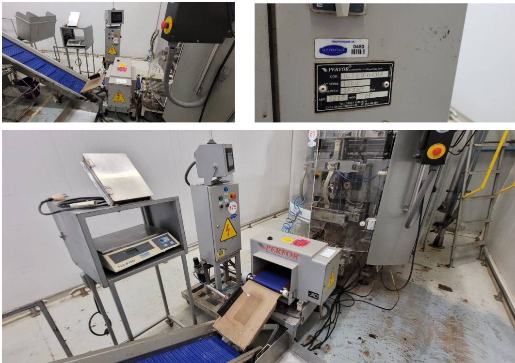
Figura 16 - Sistema controlador peso e detecção de metais – Linha 5214
