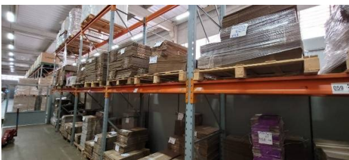
Figura 38 – Modulo de estrutura de aço
