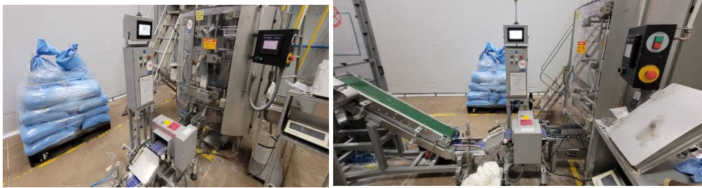
Figura 17 - Sistema controlador peso e detecção de metais – Linha 5216
