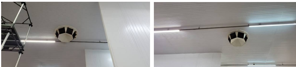
Figura 02 - Conjunto de Exaustores e Insufladores
