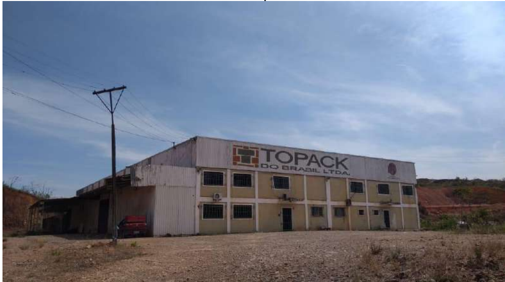
Vista da fachada frontal do Galpão existente.
