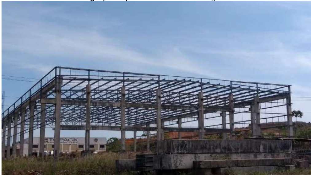
Vista do novo galpão que está em construção.
