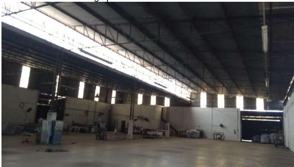
Vista interna do galpão existente em uso.
