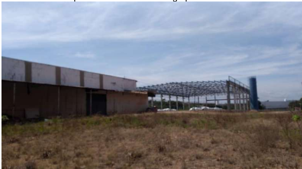
Vista do aspecto externo dos dois galpões.
