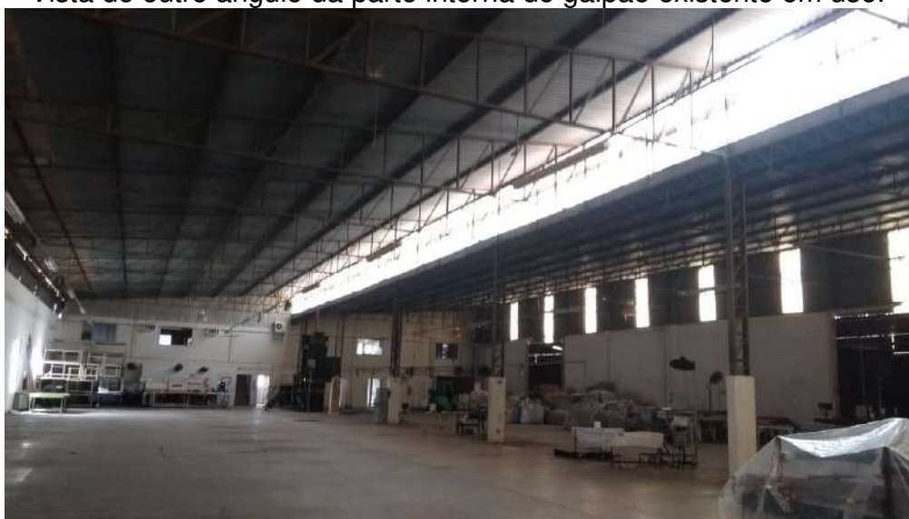
Vista de outro ângulo da parte interna do galpão existente em uso.
