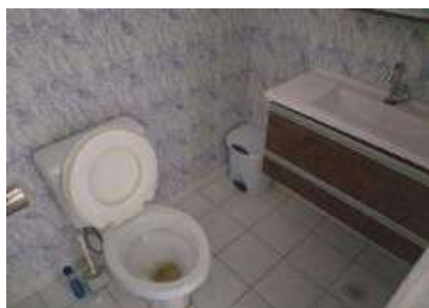
VISTA DO BANHEIRO
