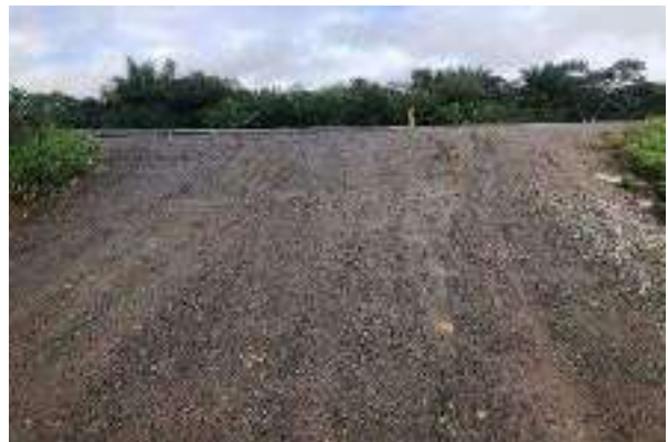
VIA DE ACESSO À RODOVIA
