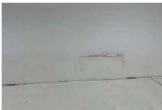
DETALHE PAREDE GALPÃO
