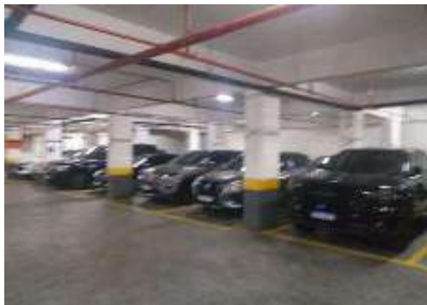
VISTA DO ESTACIONAMENTO PADRÃO DO EMPREENDIMENTO
