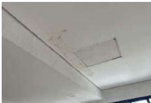
DETALHE TETO DA SALA COM BANHEIRO
