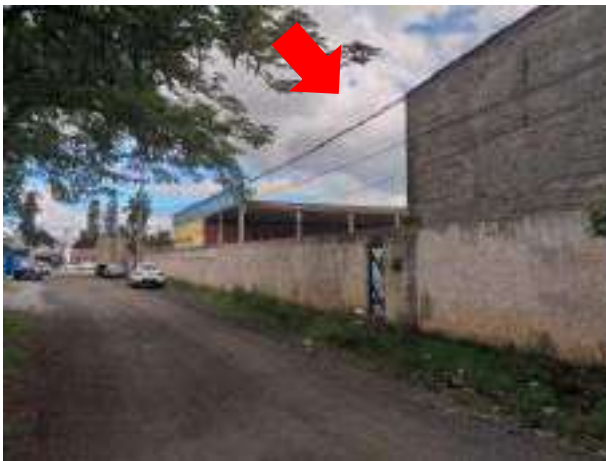
VISTA DO LOGRADOURO LATERAL
