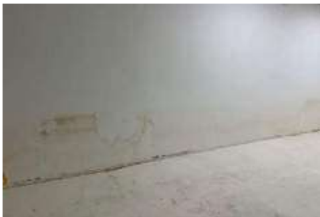
DETALHE PAREDE GALPÃO
