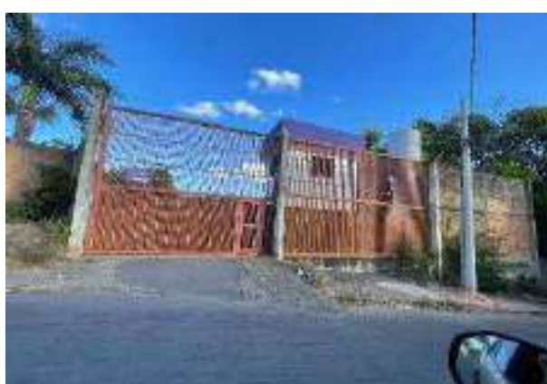
ACESSO PELA RUA MIRTES DE PÁDUA
