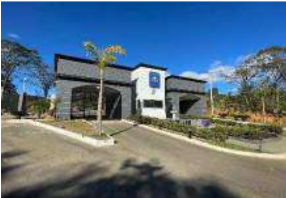
PORTARIA DO CONDOMÍNIO
