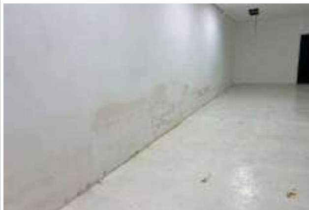
DETALHE PAREDE GALPÃO
