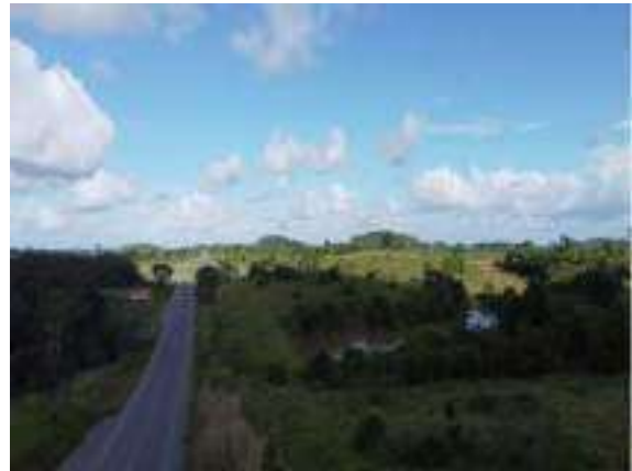
VISTA DA PISTA DE ACESSO
