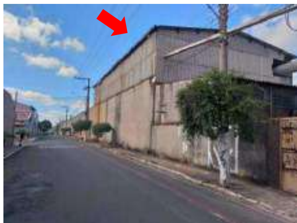
VISTA DO IMÓVEL A FRENTE DA RUA SÃO MARCOS - DIVISA DE FUNDOS
