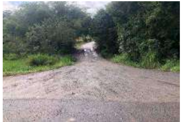
VIA DE ACESSO AO TERRENO
