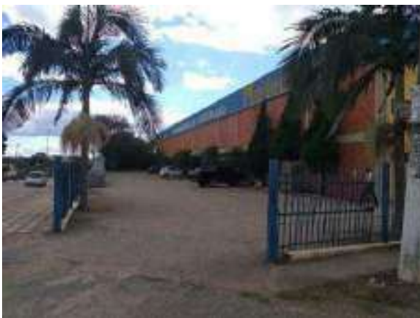
VISTA DO PORTÃO DE ACESSO
