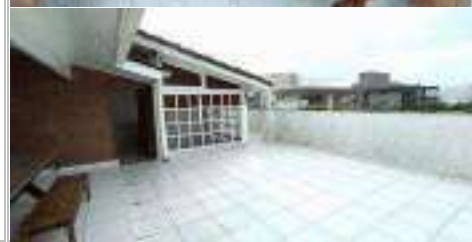
VISTA DA VARANDA / TERRAÇO (SUPERIOR)
