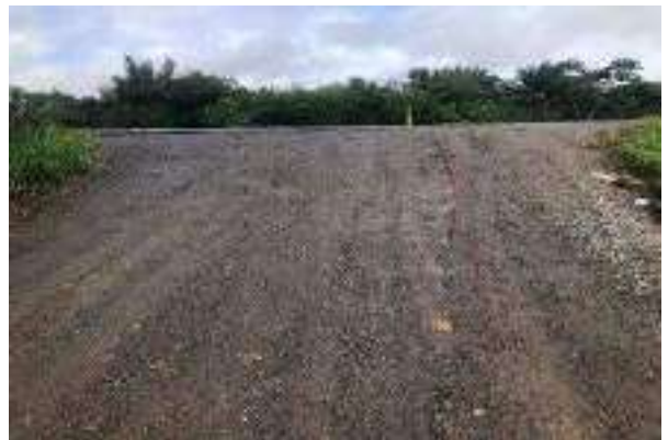
VIA DE ACESSO À RODOVIA
