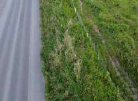
VISTA TSTADA - elevada em relação a pista
