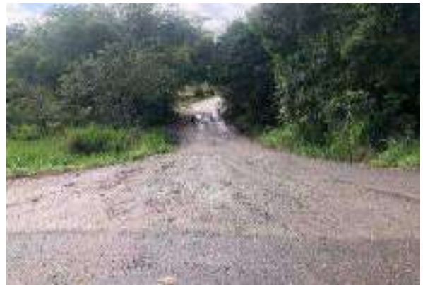
VIA DE ACESSO AO TERRENO
