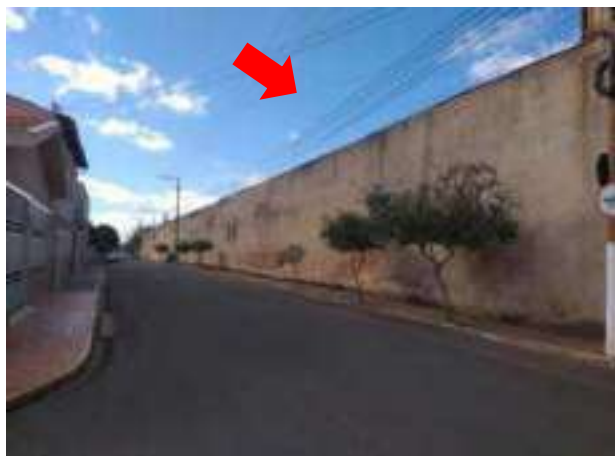
VISTA DO IMÓVEL A FRENTE DA RUA SÃO MARCOS
