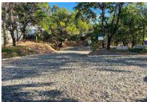
VISTA GERAL INTERNA
