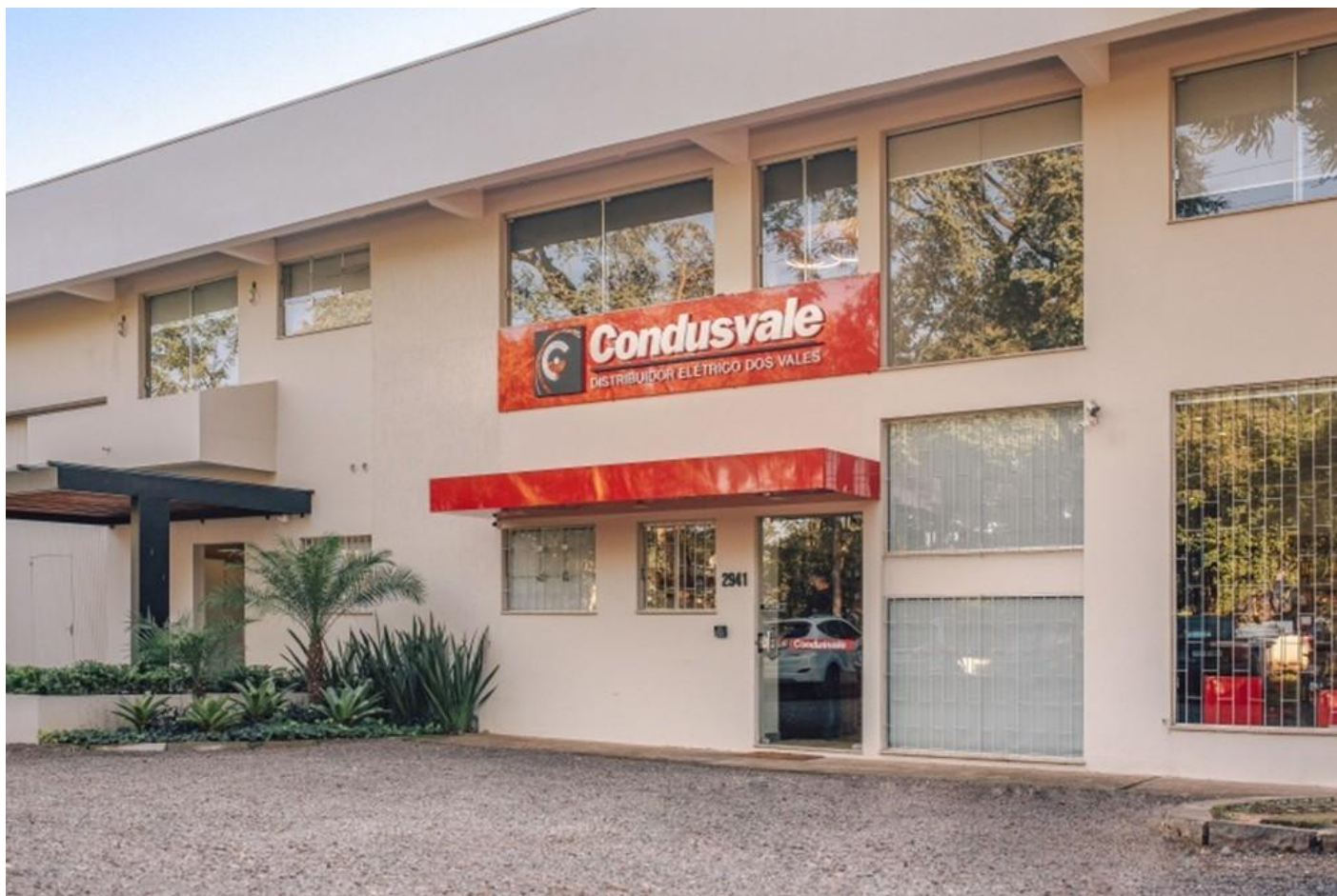
Figura 2: Sede administrativa da RECUPERANDA
