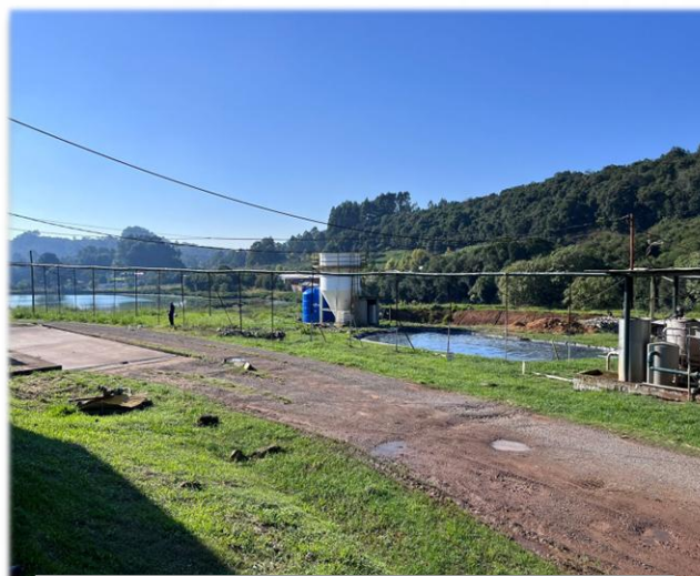
Estação de tratamento de efluentes
