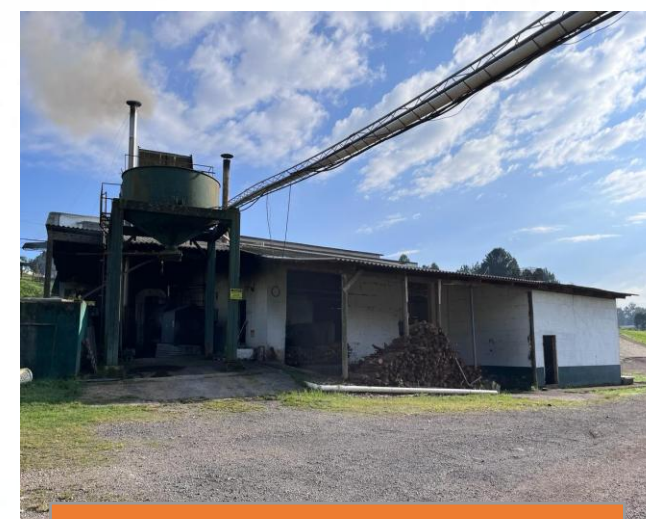
Prédio das caldeiras
