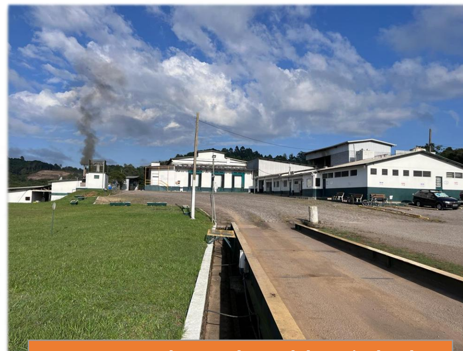
Vista para a planta industrial do imóvel sede
