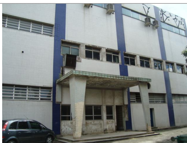
Vista Acesso Prédio
