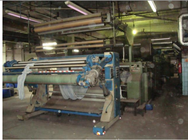
Vista Parcial Interna
