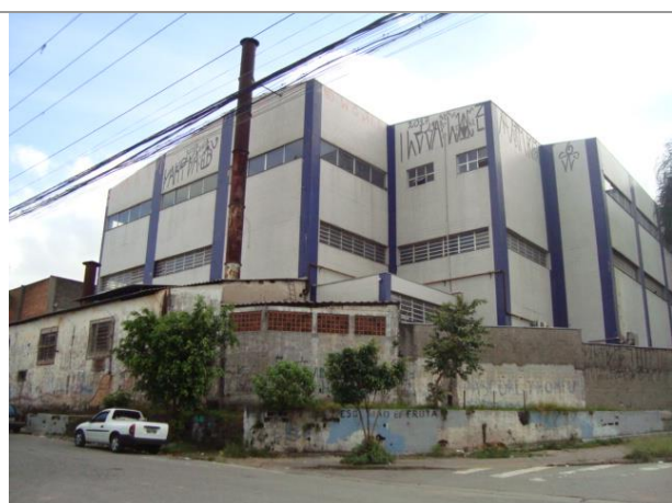
Vista Fachada – Rua Itajubá
