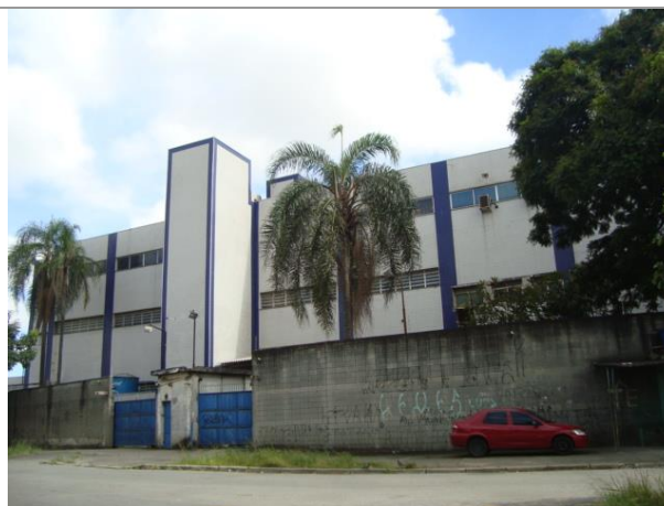
Vista Fachada – Av. Santana da Boa Vista
