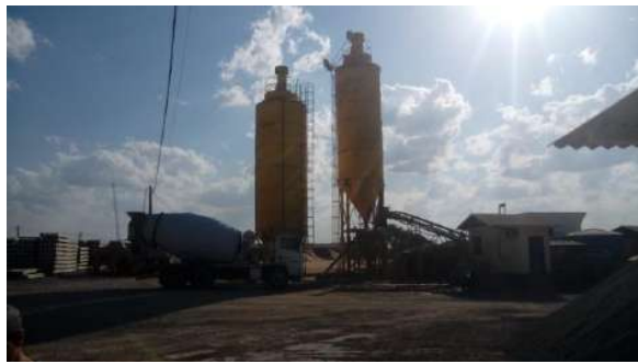
- EQUIPAMENTOS DA FÁBRICA DE DORMENTES -
