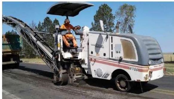
- FREZADORA DE ASFALTO -
