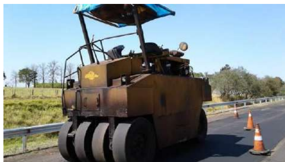
- COMPACTADOR DE ASFALTO -
