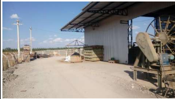
- EQUIPAMENTOS DA FÁBRICA DE DORMENTES -
