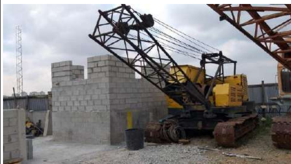
- ESCAVADEIRA A CABO -
