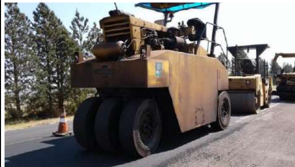
- COMPACTADOR DE ASFALTO -
