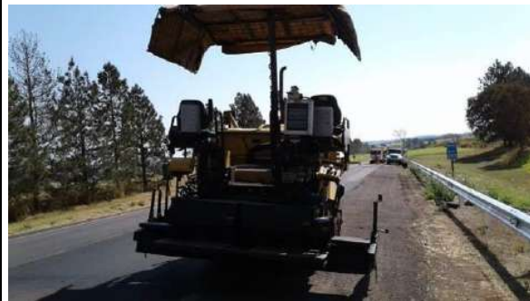
- ACABADORA DE ASFALTOS -
