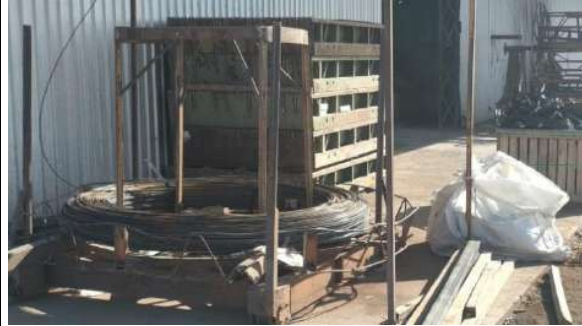
- EQUIPAMENTOS DA FÁBRICA DE DORMENTES -
