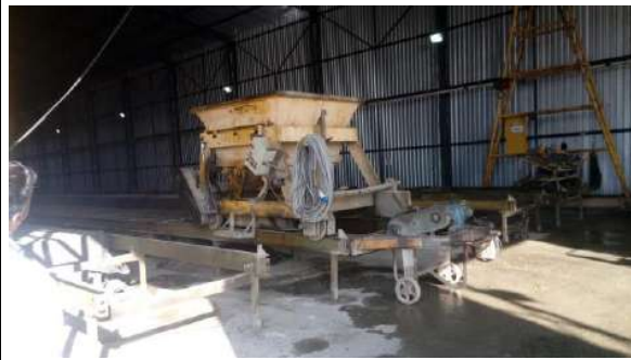
- EQUIPAMENTOS DA FÁBRICA DE DORMENTES -
