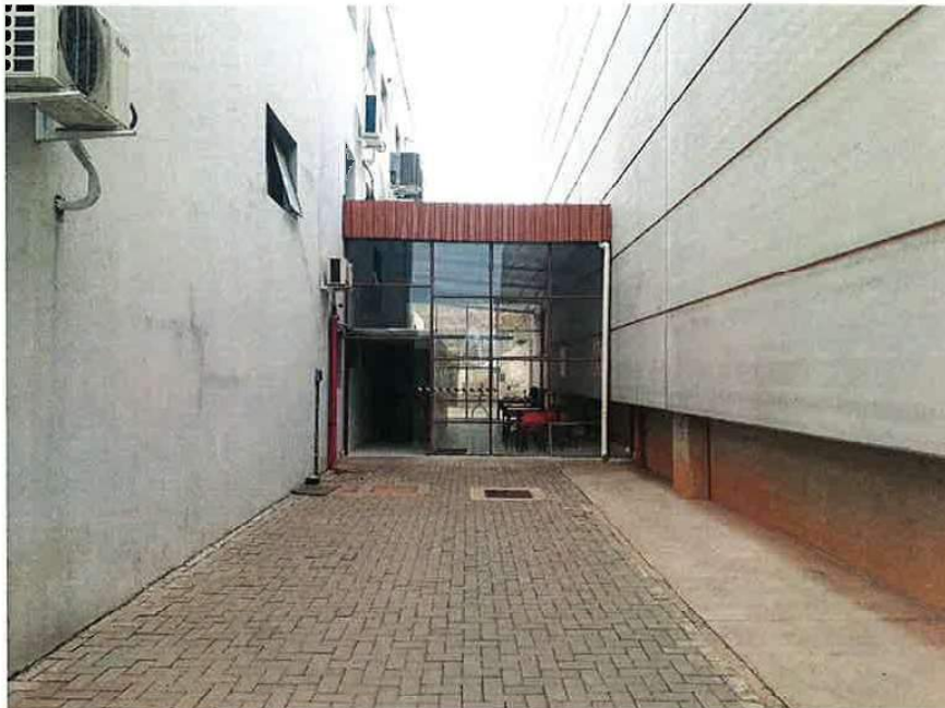
Foto 20 - Vista do Corredor que divide área Administrativa e Fábrica.
