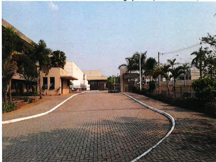
Foto 05 – Vista da Portaria de acesso aos galpões e portaria central.
