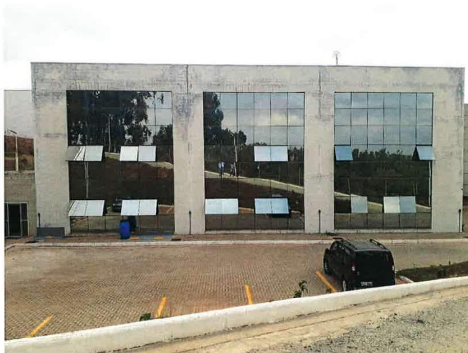
Foto 07 – Vista da frente do Galpão onde está a área administrativa.
