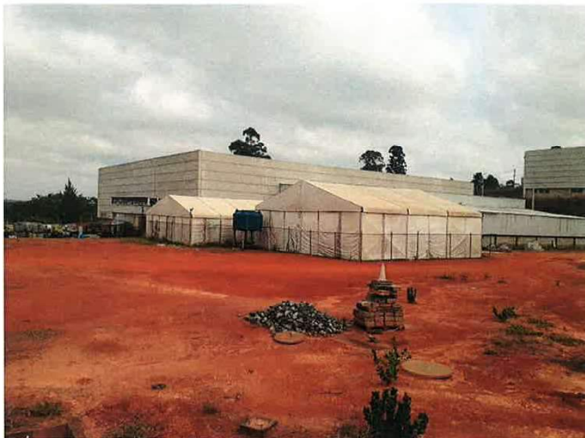
Foto 22 - Vista dos Galpões de apoio.
