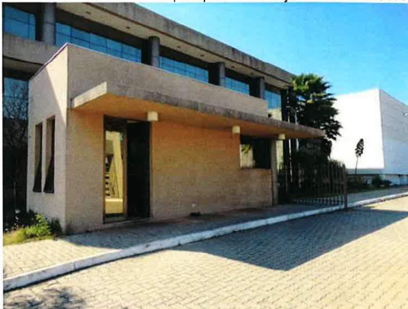
Foto 06 – Portaria de acesso principal e identificação de entrada do I A
