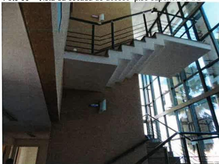
Foto 09 – Vista da escada de acesso piso superior do IA.
