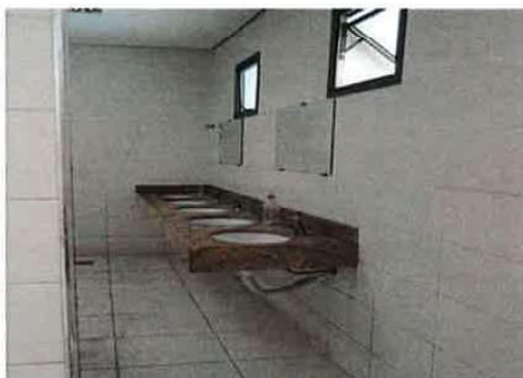
Foto 13 e 14 – Vista dos Banheiros do IA
