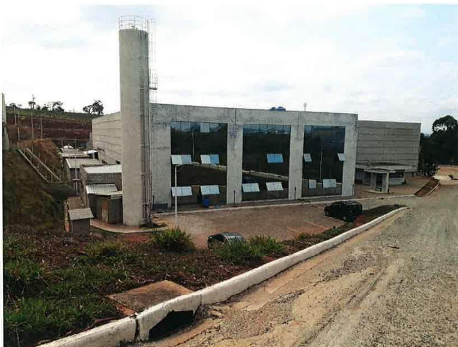
Foto 01 – Vista do Predio área administrativa do IA.
