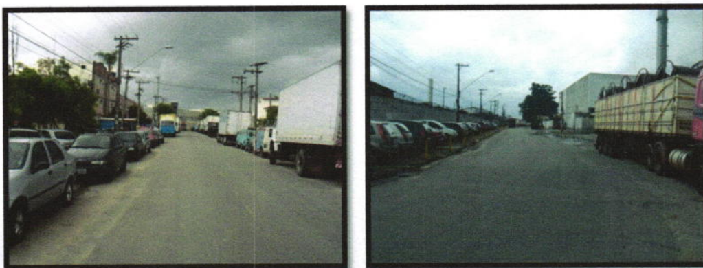
Logradouro de situação
